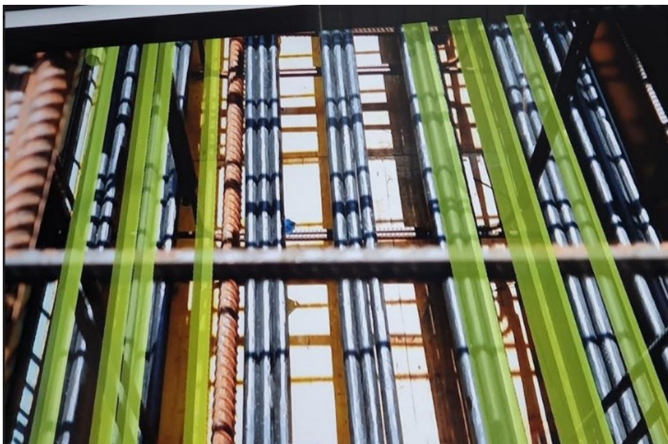
Kuva 2. Palkkirauditus Oopsin rakennustyömaa Espoon Leppävaara. Trimblen SiteVisionilla katsottuna (NCC 2021)
