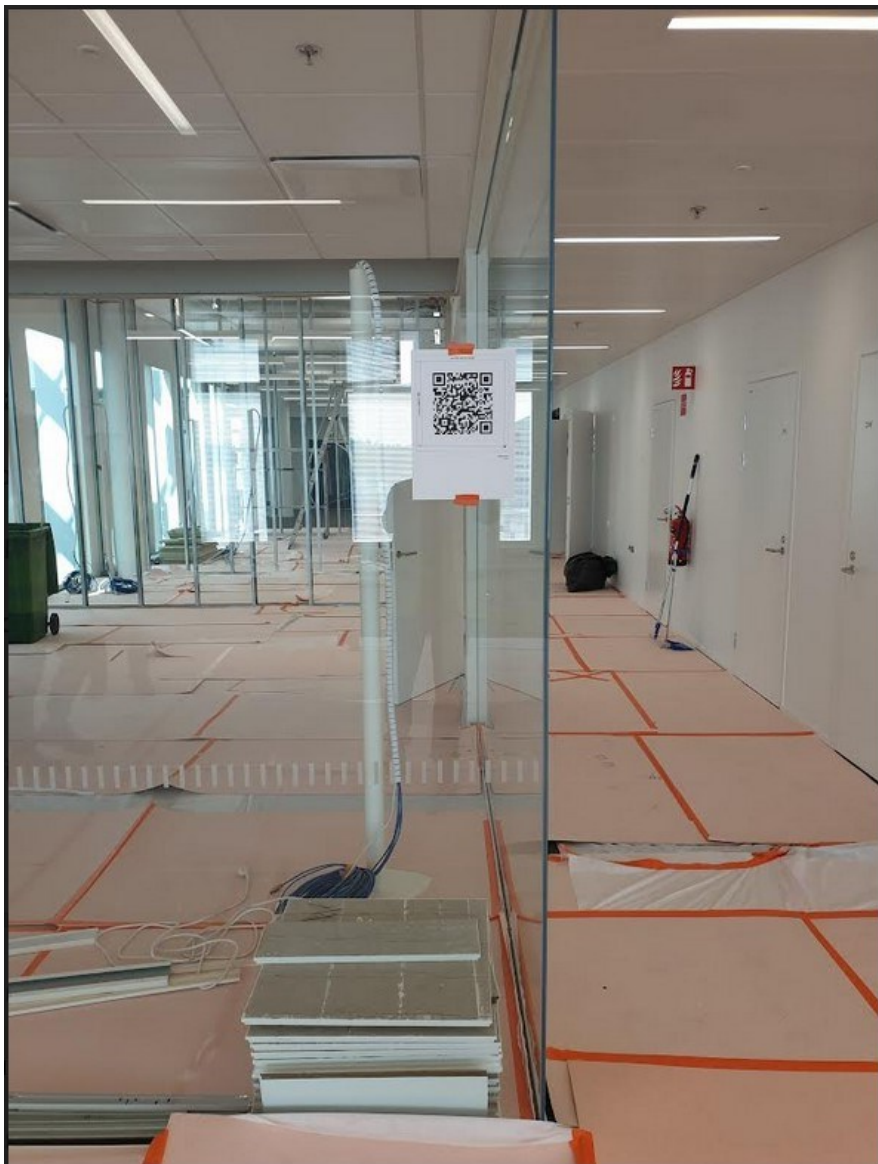
Kuva 8. QR-koodi Oopsin rakennustyömaa Espoon Leppävaarassa (Ncc 2021)
