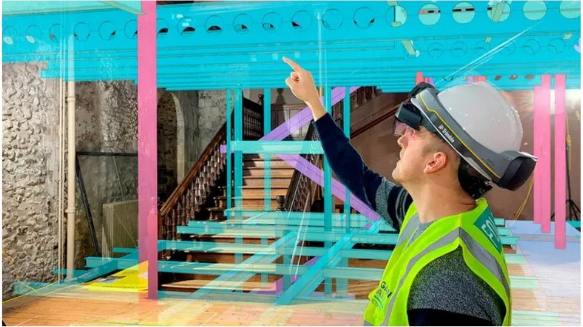
Kuva 5. Yhdistetyn todellisuuden käyttäminen työmaalla. (Rakennuslehti 2021)
