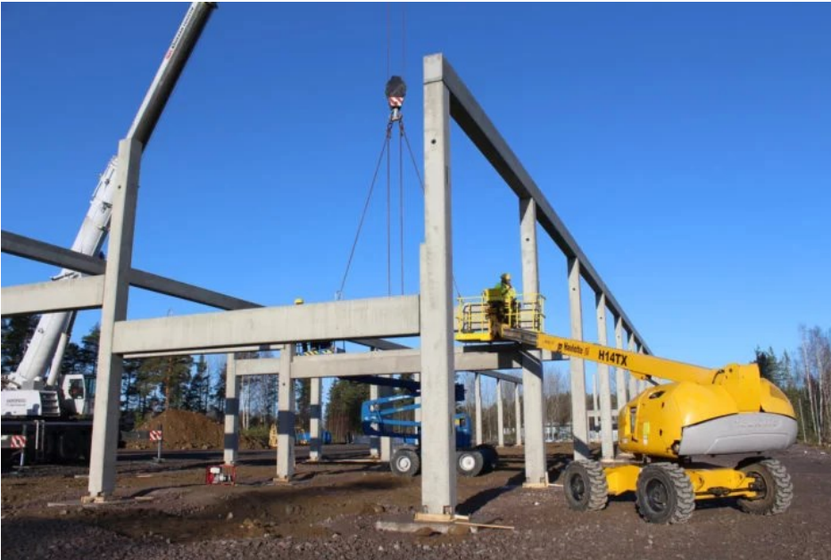
Kuvio 6 Betonisen pilari- palkkirungon asennusta. (Antola, T. 2015)
