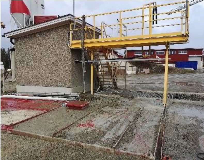
KUVA 5. Betonin kuljetuskaluston pesuun rakennettu pesupaikka
