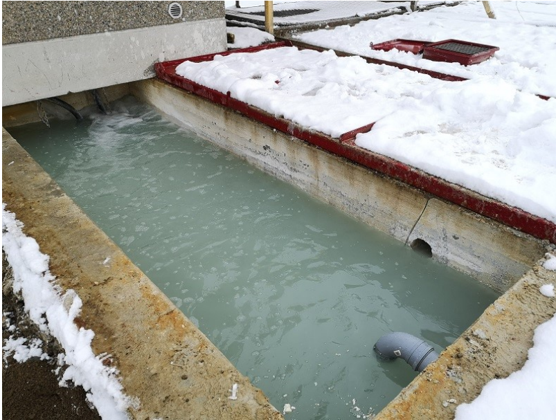
KUVA 10. Puhdasvesiallas juuri täytettynä lietteen poiston ja muutostöiden jälkeen
