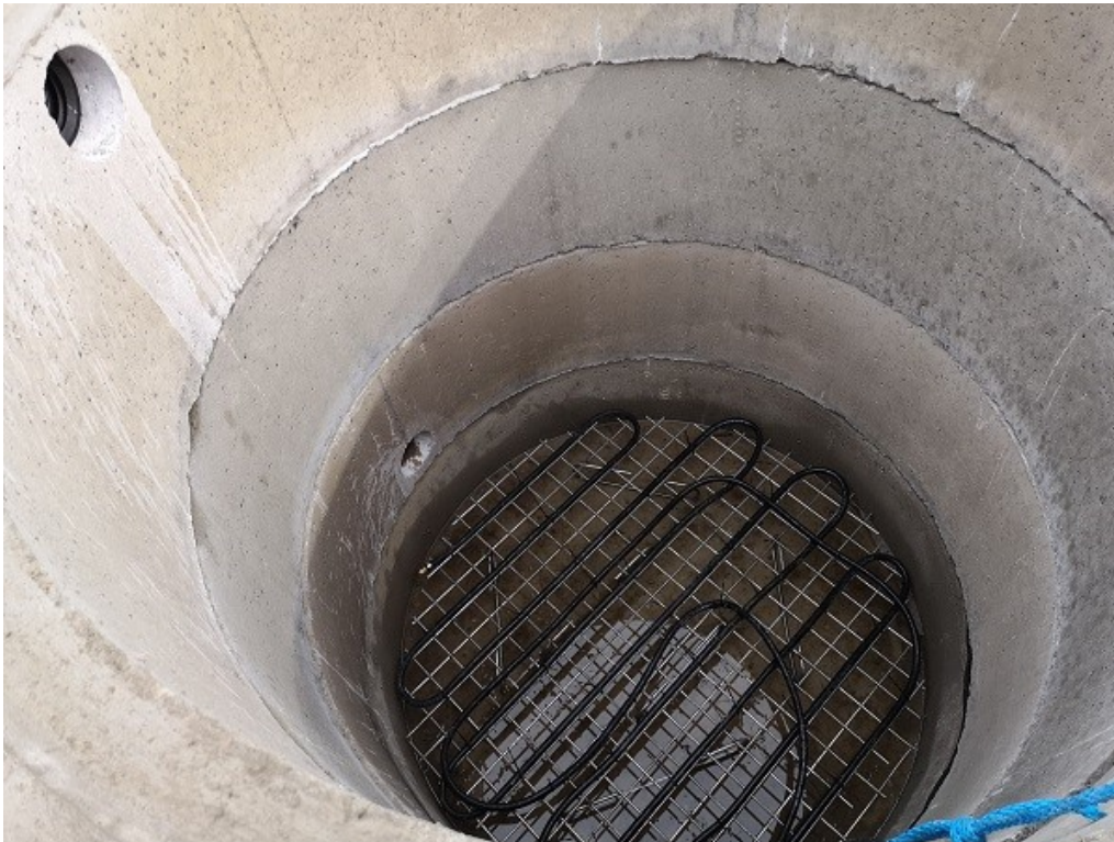
KUVA 12. Kaasunsyöttöletku asennettuna neutralointikaivoon
