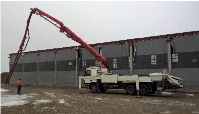
KUVA 4. Betonin pumppaamalla siirtämiseen tarkoitettu betonipumppuauto
