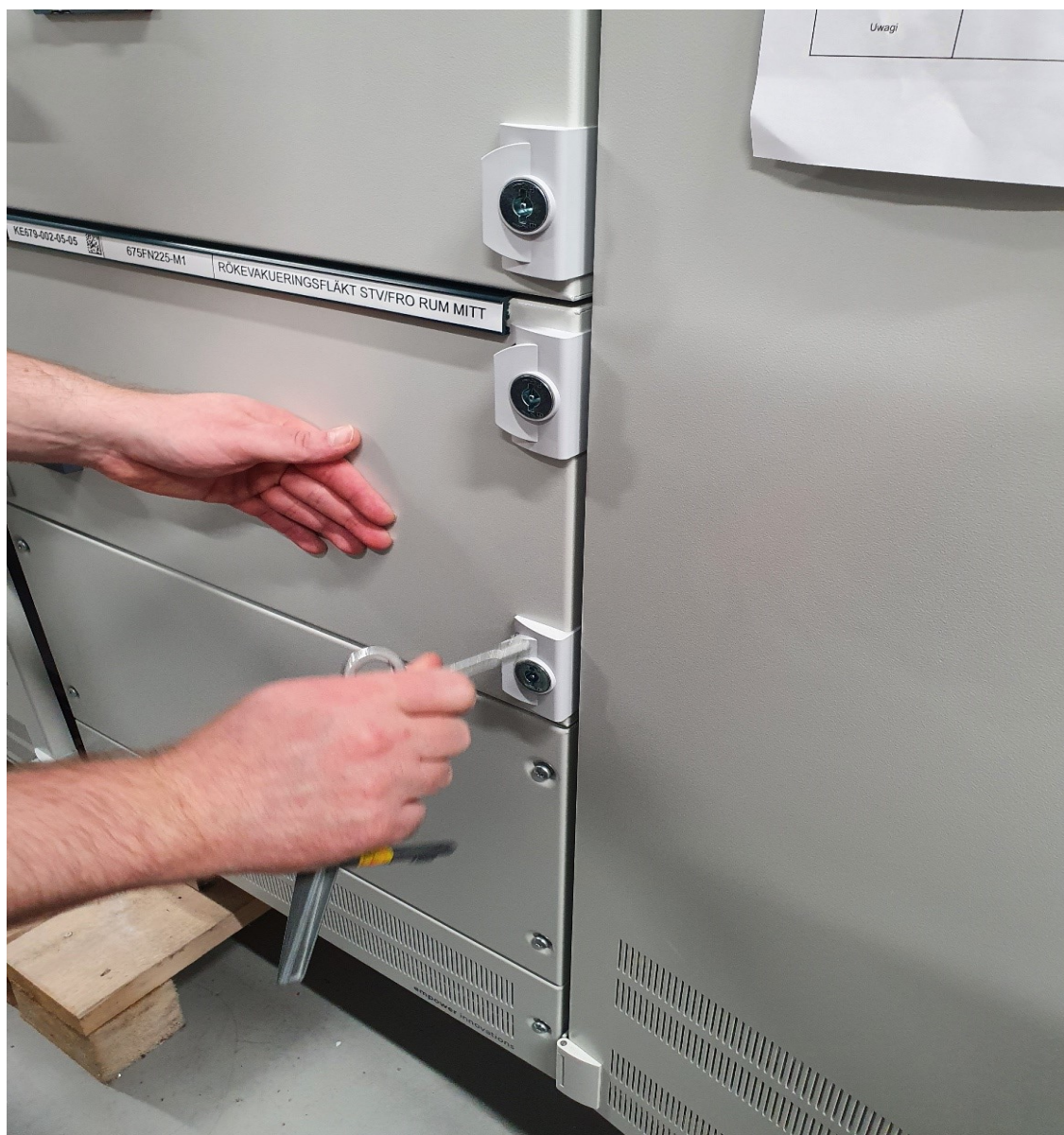
KUVA 8. Ovien lukkojen testaus
