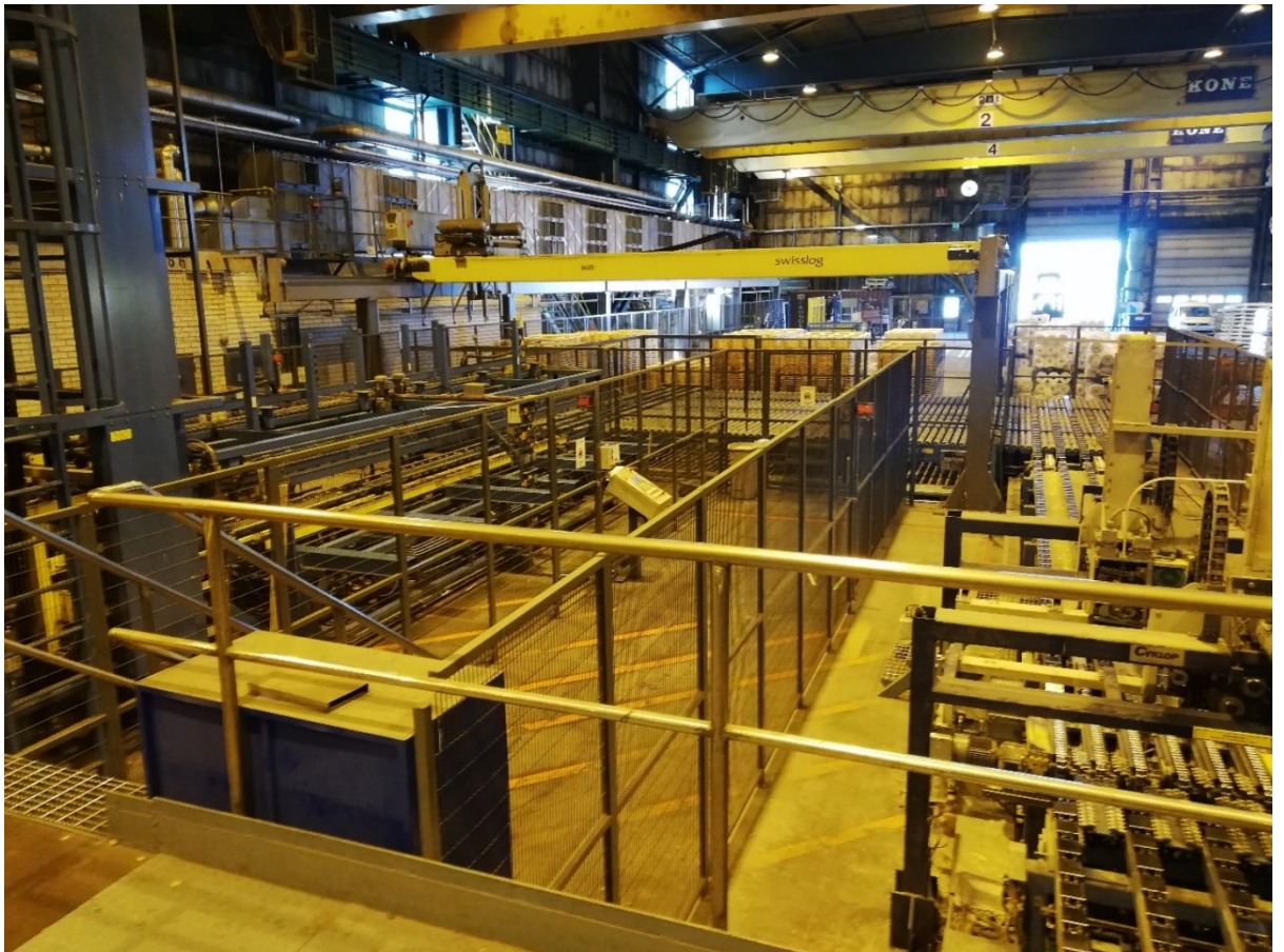
Kuva 22. Automaattinen levyjenpakkauslinja ALP.
