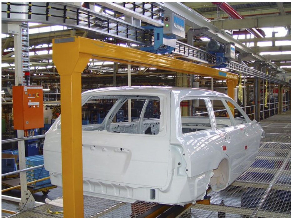
Kuva 41. Kiskoille asennettava IPT-järjestelmä autotehtaalla Australiassa. (Conductix-Wampfler 2021b.)
