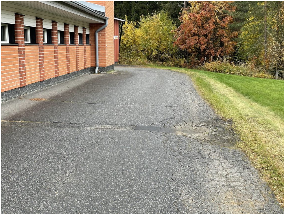
Kuva 10. Rakennuksen itäpuolella asfaltin liittymäkohta nurmialueisiin
