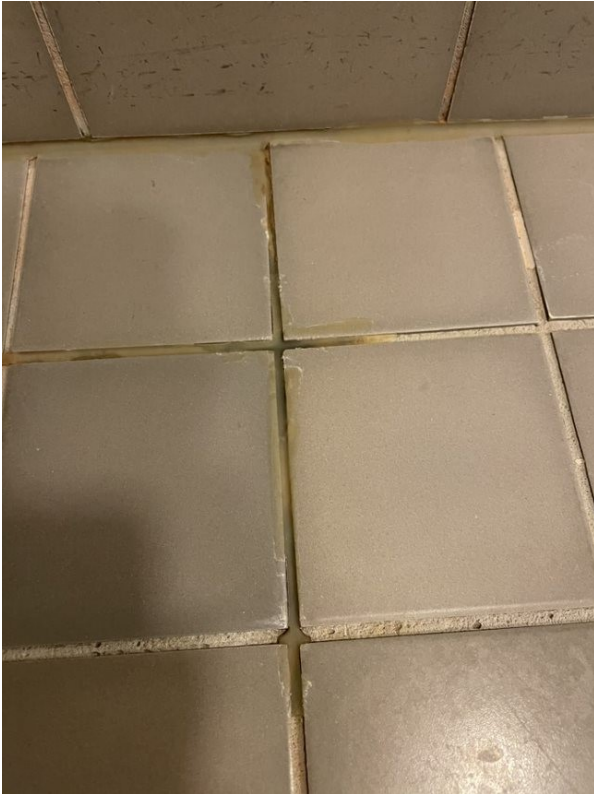
(Kuva 14. Suihkun lattialaattojen saumaa korjattu silikonilla)
