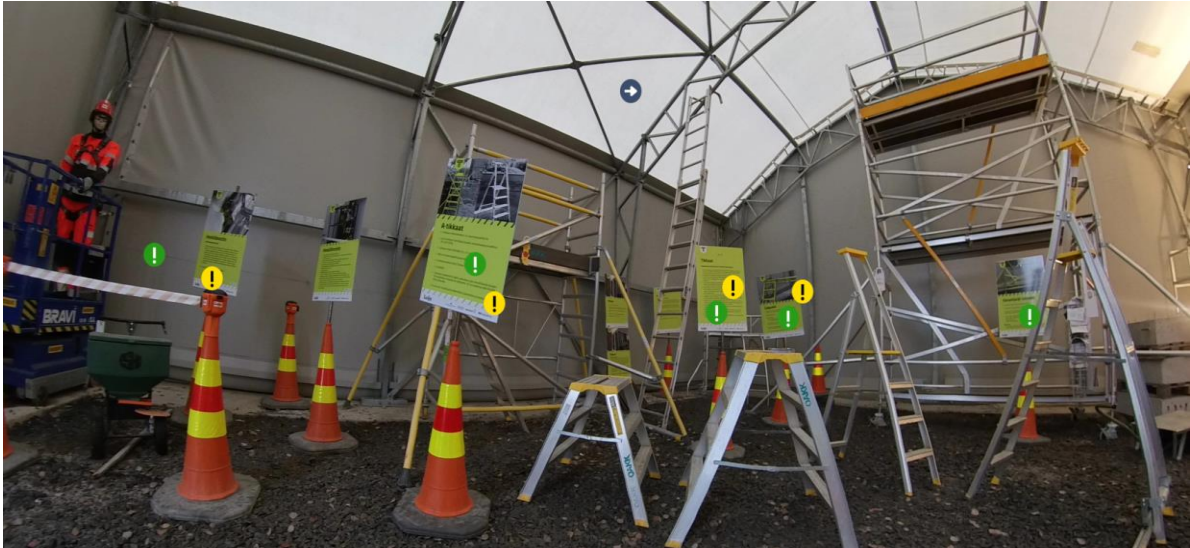
KUVA 10. Työmaalla käytettävät apuvälineet
