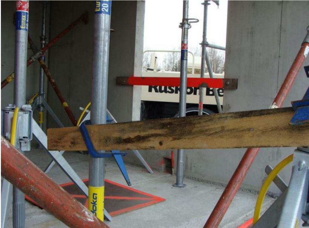
KUVA 6. Ikkuna-aukkojen suojaaminen
