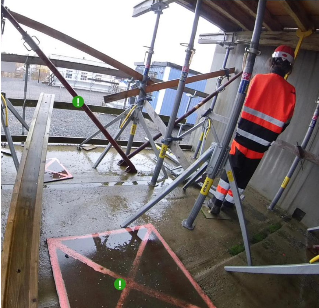
KUVA 5. Muottityöt ja läpivientien suojaus
