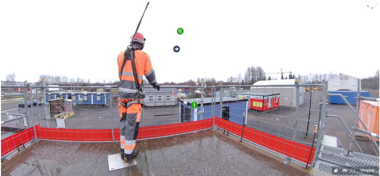
KUVA 2. Perustus- ja runkorakentamisen rasti
