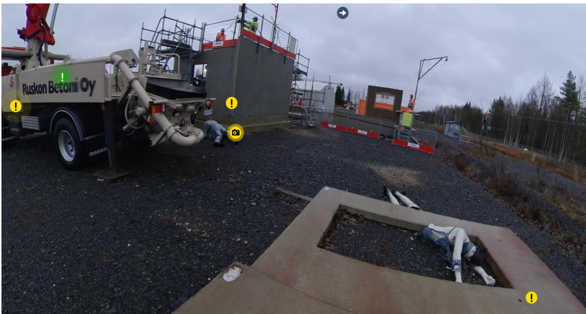
KUVA 3. Perustus ja runkorakentamisen rasti
