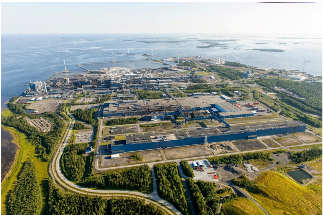
Kuva 1. Outokummun Tornion tehdasalue. (Outokumpu Stainless Oy 2021b.)
