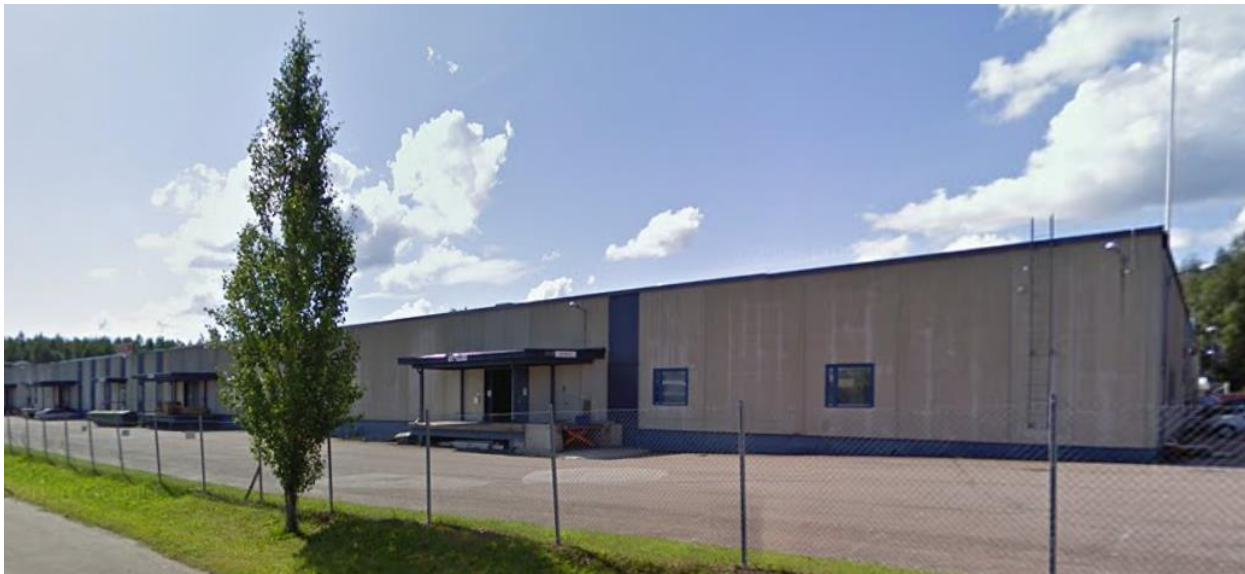
KUVA 5. Teollisuus A1 kiinteistön julkisivu (Google Maps 2009)
