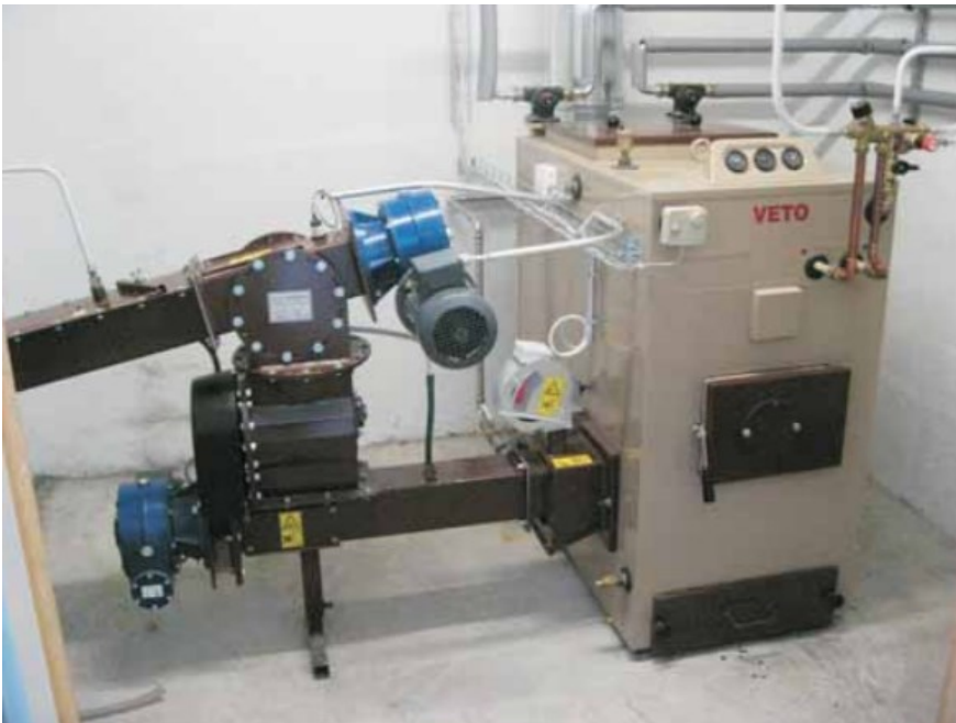
Kuvio 9. Hakelämmitysjärjestelmä poltin ja kattila. (Viirimäki ym. 2008.)
