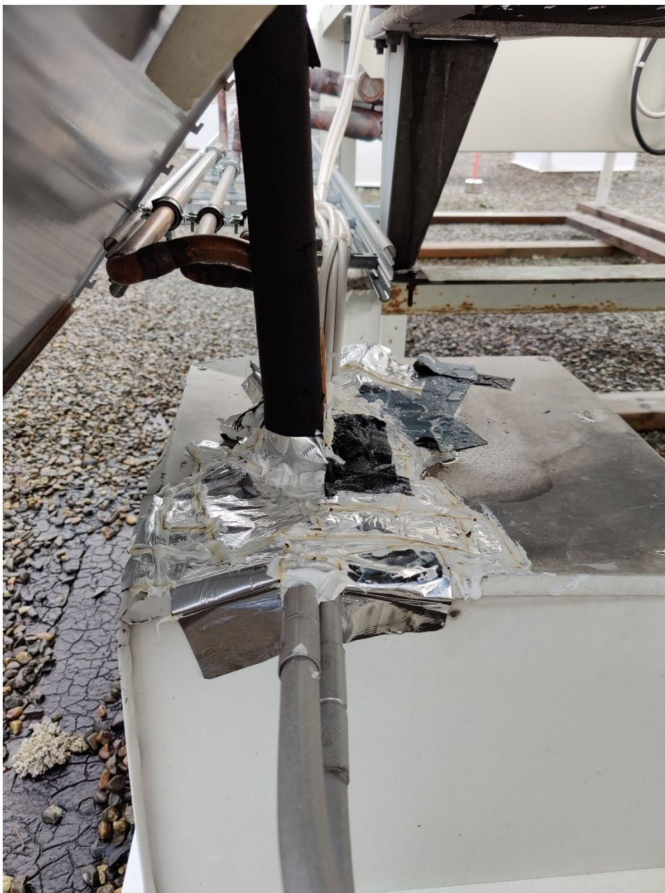
Kuva 33. Kompressorikonehuoneen yläpuolella olevan vesikaton läpiviennin vuotokohdan korjaus alumiiniteipillä ja massalla.
