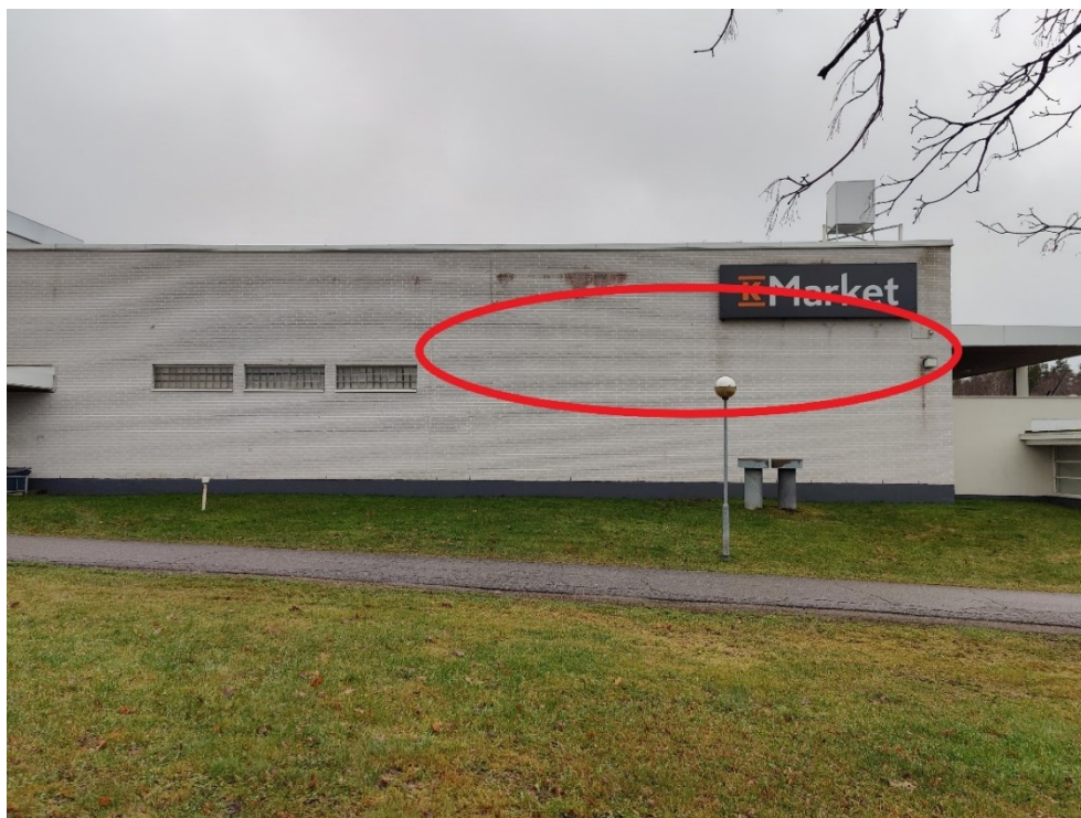
Kuva 27. Kameralla otettu kuva rakennuksen itäpäädystä.
