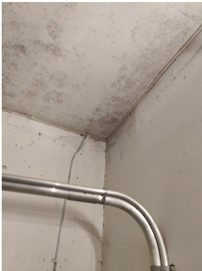
Kuva 18. Kameralla otettu kuva lämpövuotosaumasta.
