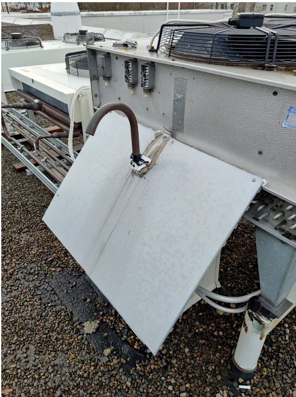
Kuva 34. Vesikaton läpiviennin vuotokohdan korjaus viistoon asennetulla peliillä.
