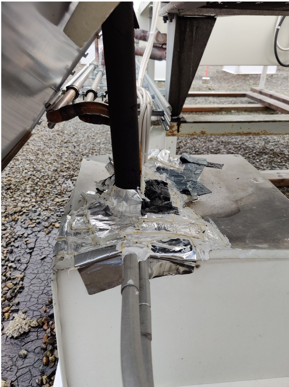
Kuva 34. Kompressorikonehuoneen yläpuolella olevan vesikaton läpiviennin vuotokohdan korjaus alumiiniteipillä ja massalla.
