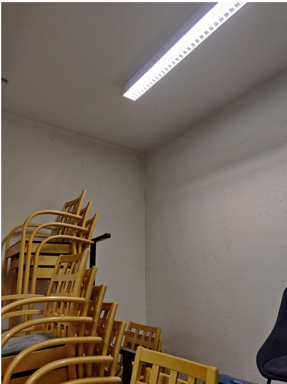
Kuva 16. Kameralla otettu kuva lämpövuotosaumasta.
