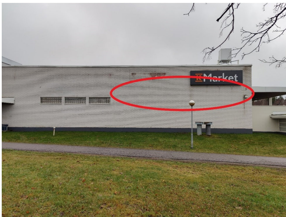
Kuva 28. Kameralla otettu kuva rakennuksen itäpäädyssä.
