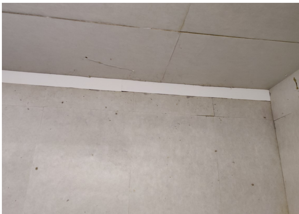
Kuva 32. Kameralla otettu kuva IV-konehuoneen saumakohdista.
