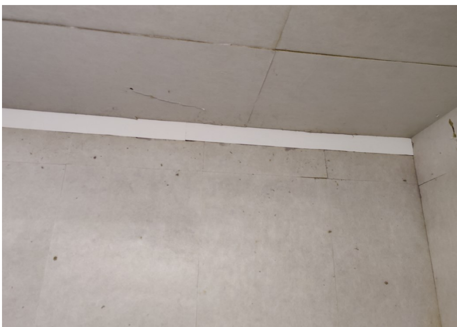
Kuva 31. Kameralla otettu kuva IV-konehuoneen saumakohdista.
