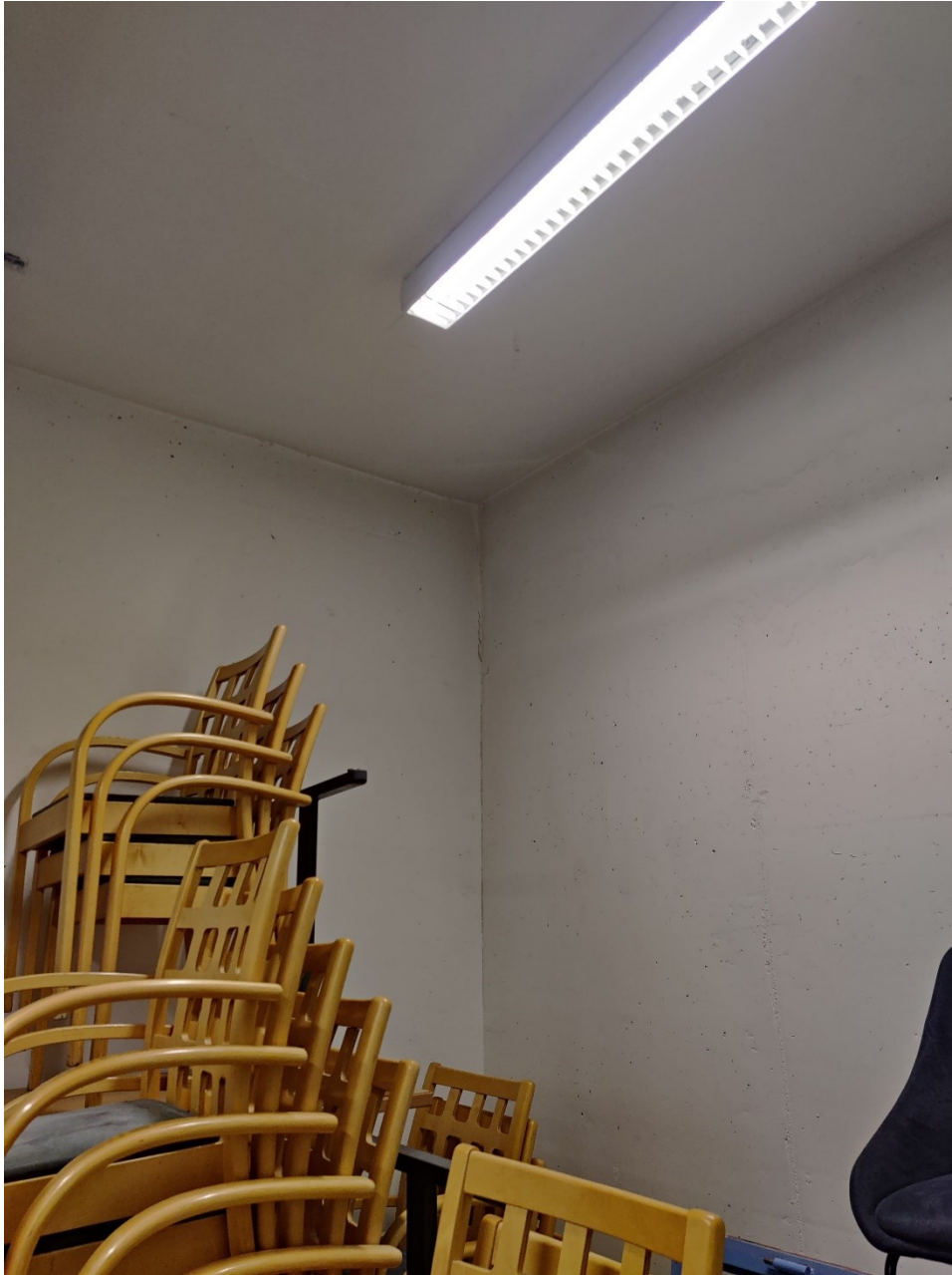
Kuva 15. Kameralla otettu kuva lämpövuotosaumasta.
