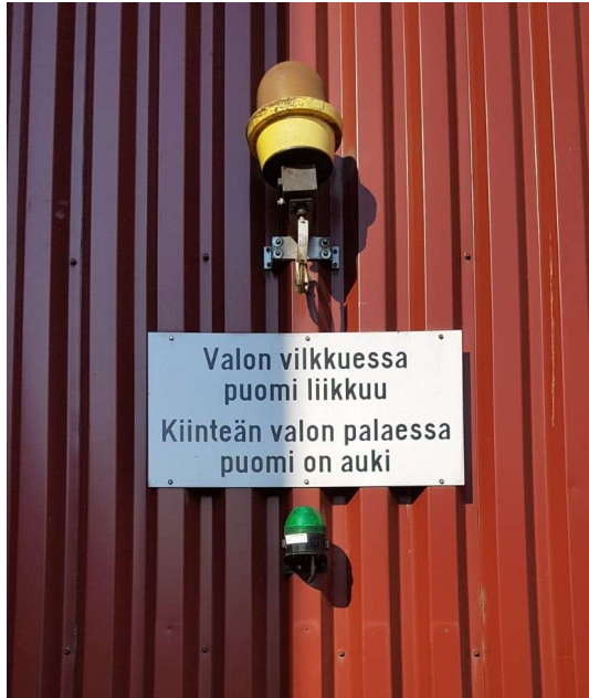
Kuva 16. Kippipaikan seinällä olevat valot ja ohjeteksti. Kyltti on selite ylemmälle valomajakalle, alemman valon osalta puuttuu ohjekyltti kokonaan (kuva Karoliina Kärkäs).
