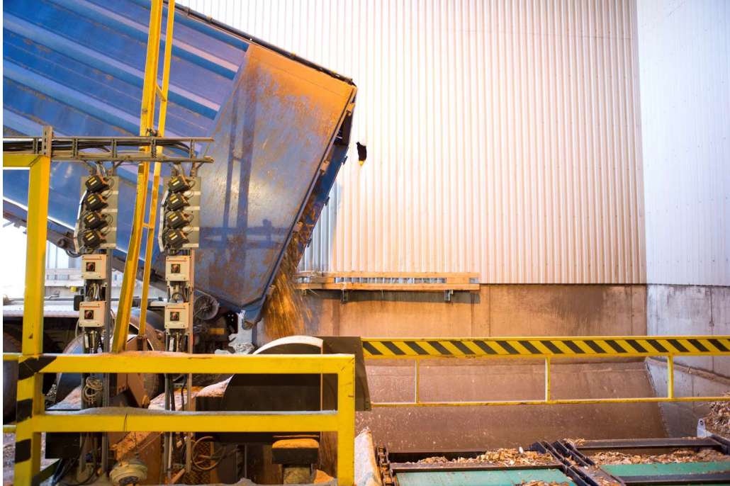
Kuva 7. Peräkippiauto purkamassa Vanajan voimalaitoksen siiloon (kuva Karoliina Kärkäs).
