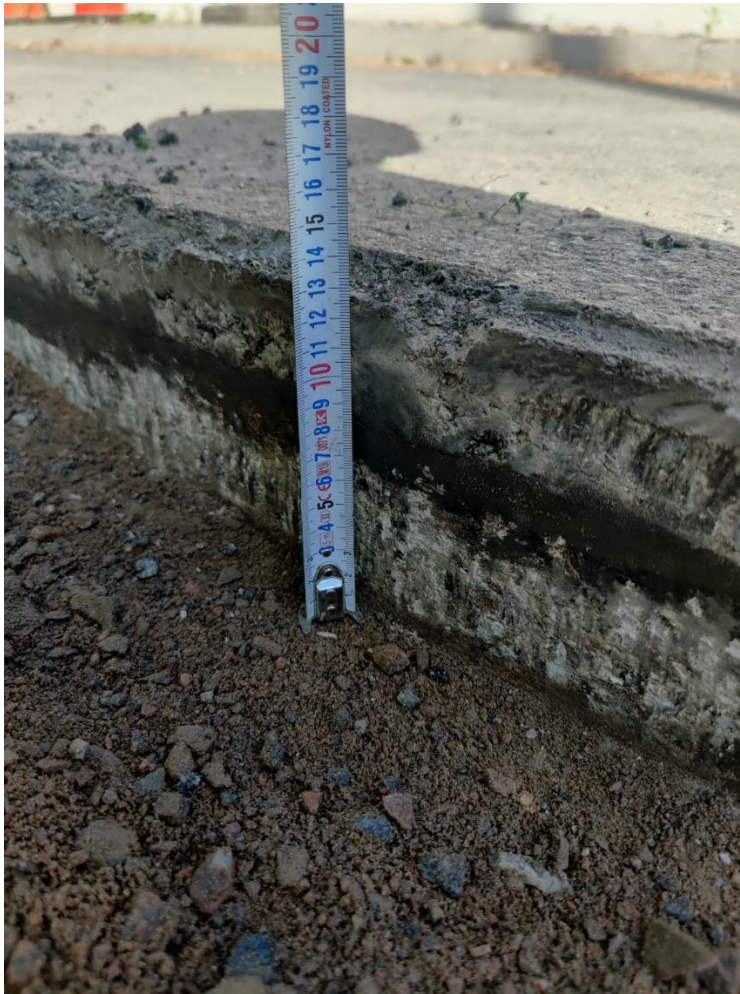
Kuva 13. Työkohteessa Matinlahdenrannan kevyen liikenteen väylän tupla-asfaltointi
