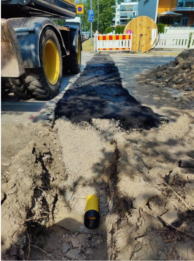
Kuva 12. Kevyen liikenteen väylältä kaapeliputken ympärille tehty massanvaihto ja päällyste korvattu öljysoralla.
