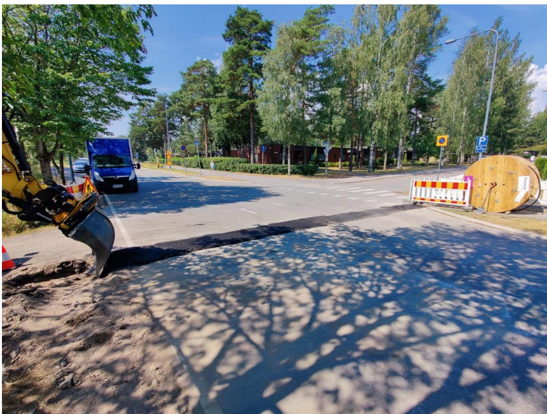
Kuva 14. Nuottaniementie tienalitus ja paikkaus väliaikaisella pinnoitteella.
