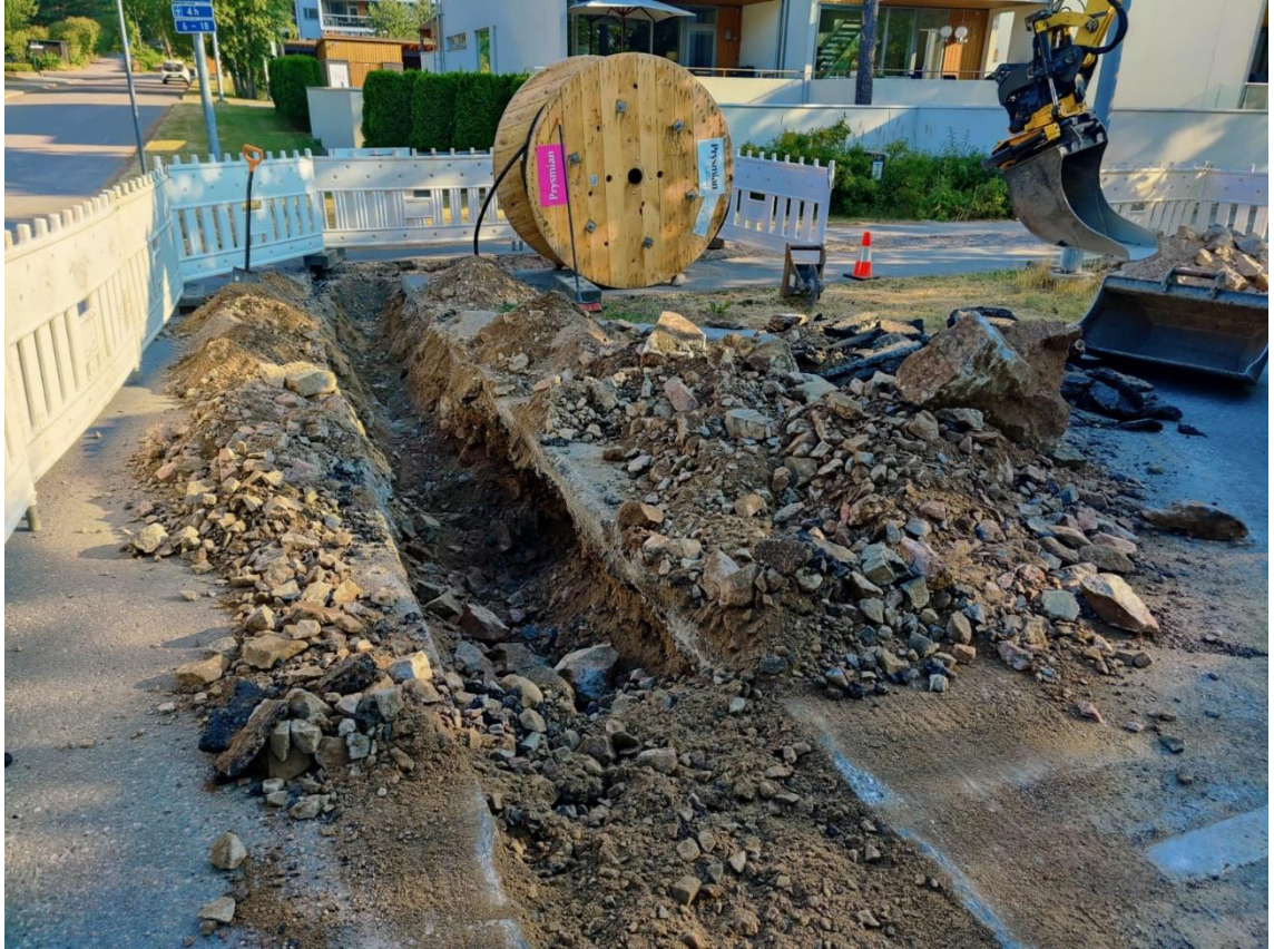
Kuva 11. Kaivutyön aikainen kuva Matinlahdenrannasta kevyen liikenteen väylältä
