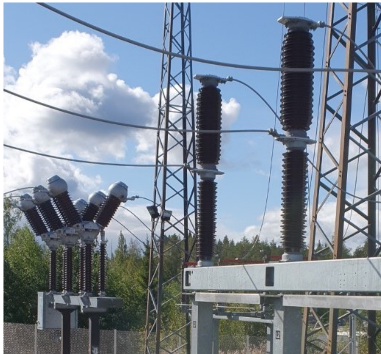
Kuva 2. 110 kV katkaisijoita.
