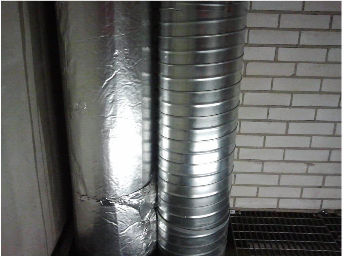
Kuva 8. Kuva kuilun sisäpuolelta. Ilmastointikanavat ovat osittain jäämässä tulevan oven eteen.
