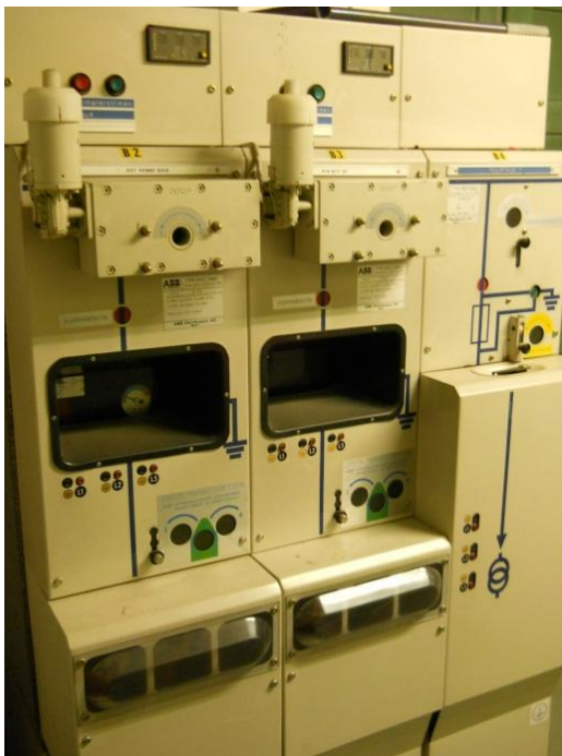
KUVA 9. M0708 KJ-kojeisto
