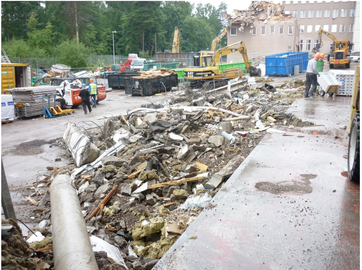
Kuva 4. Lajittelematonta purkujätettä työmaalla.
