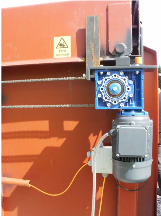
KUVA 4. Moottori asennettuna paikalleen
