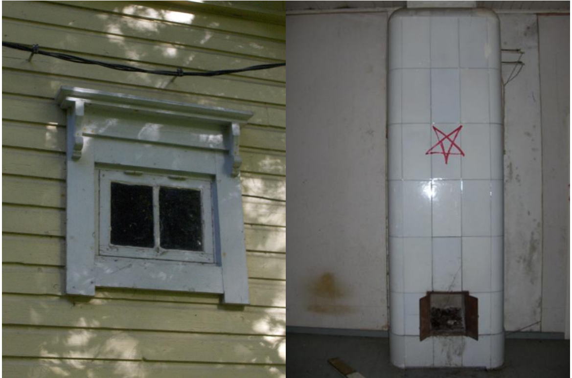
Kuva 2 Ikkunan pielilistoitus ja kamarin kaakeliuuni
