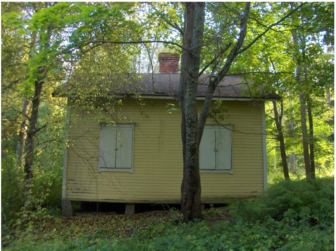
Kuva 3 Routinut perustus ja kaadettavat puut
