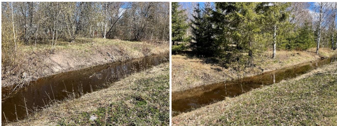
Kuva 18 ja Kuva 19. Merrasojan penkereen nykytilaa. (Kuvat: Janette Kruunari)
