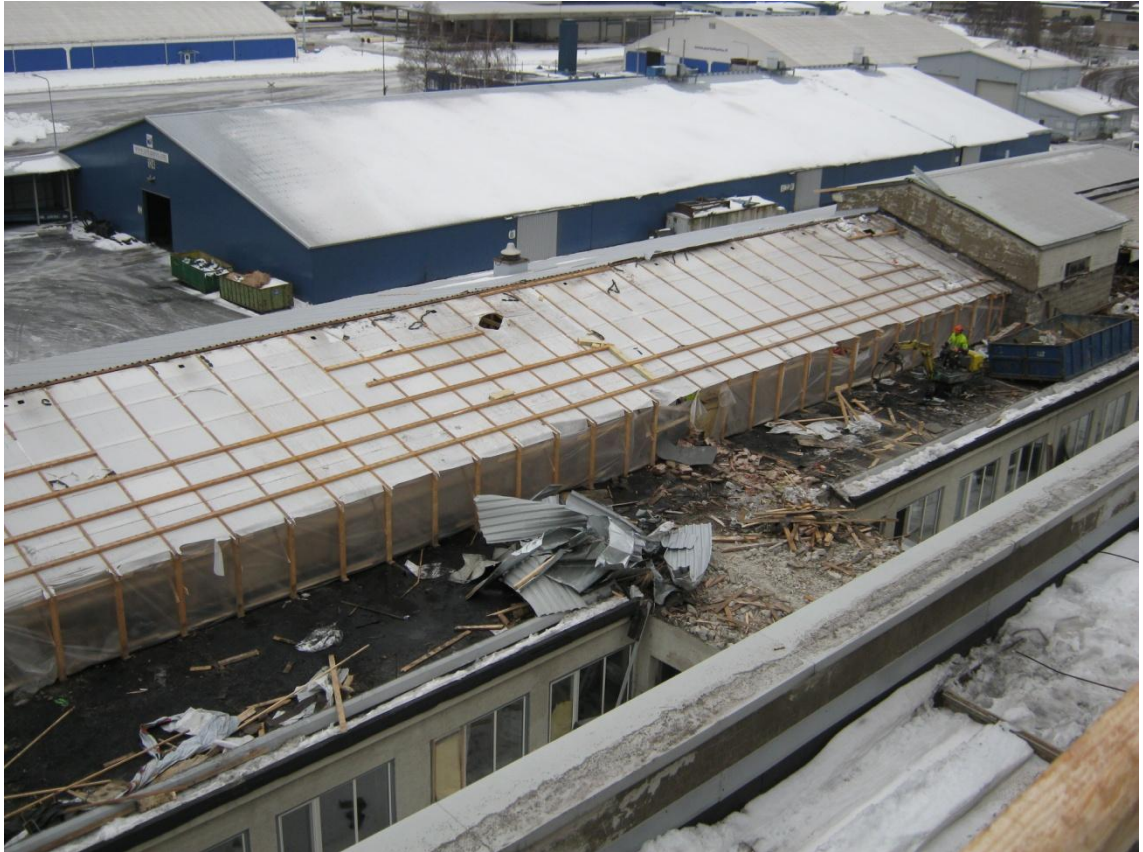
Kuva 5. Vanhoja vesikattorakenteita käytettiin sääsuojana.
