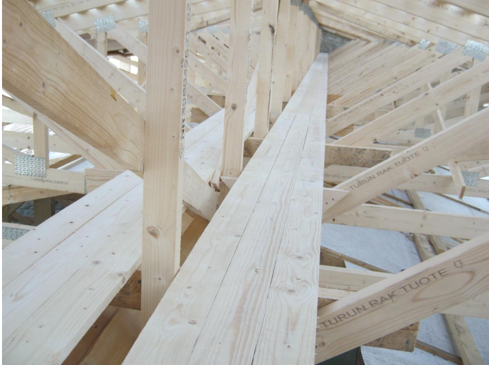
Kuva 21. Yläpohjan kulkusillat.
