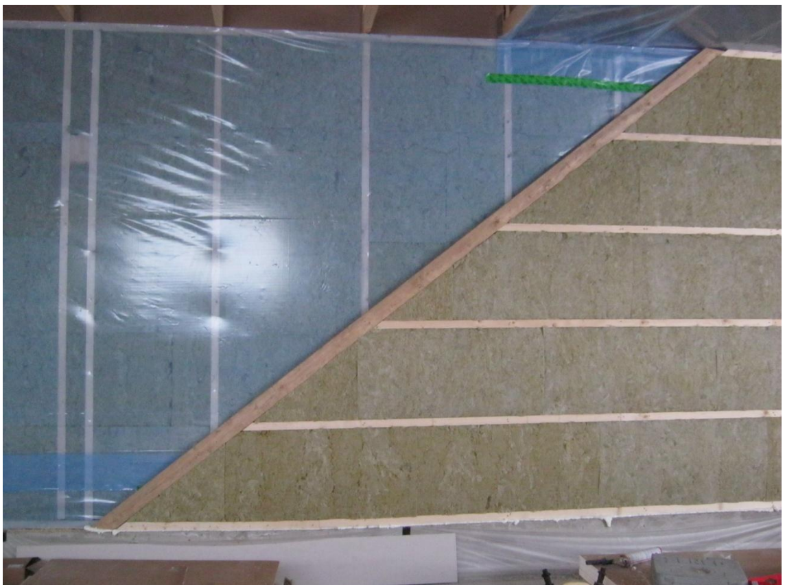
Kuva 28. Seinän lämmöneristys ja höyrynsulku.
