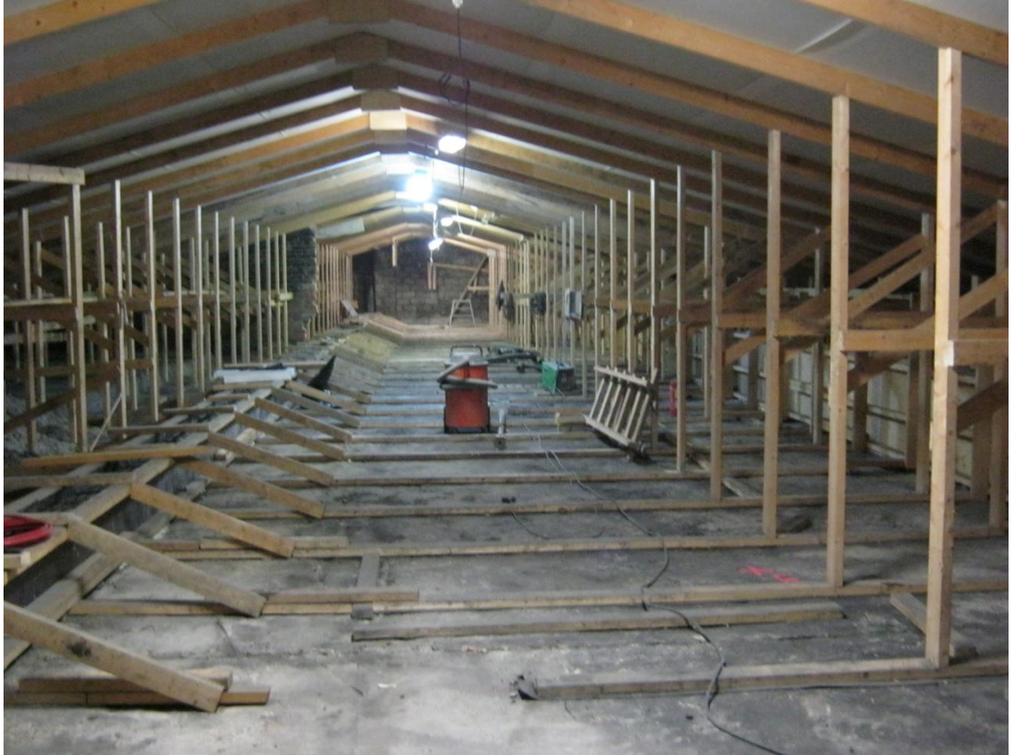
Kuva 9. Palkkimuotit.
