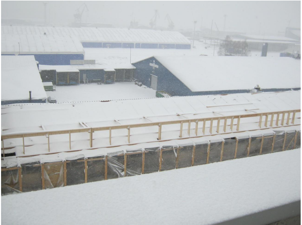
Kuva 16. Puurungon pystytys.
