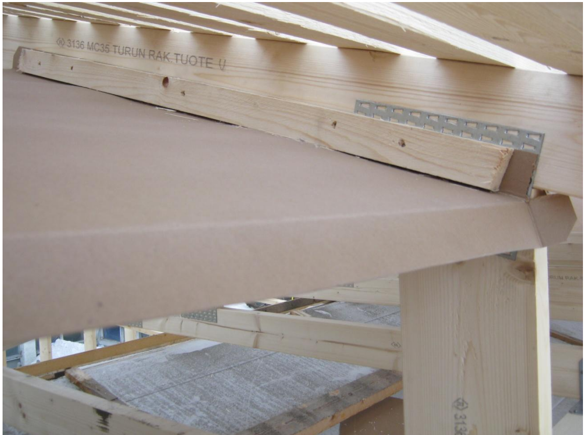
Kuva 20. Kattoristikoiden väliin asennettava tuulenojain.
