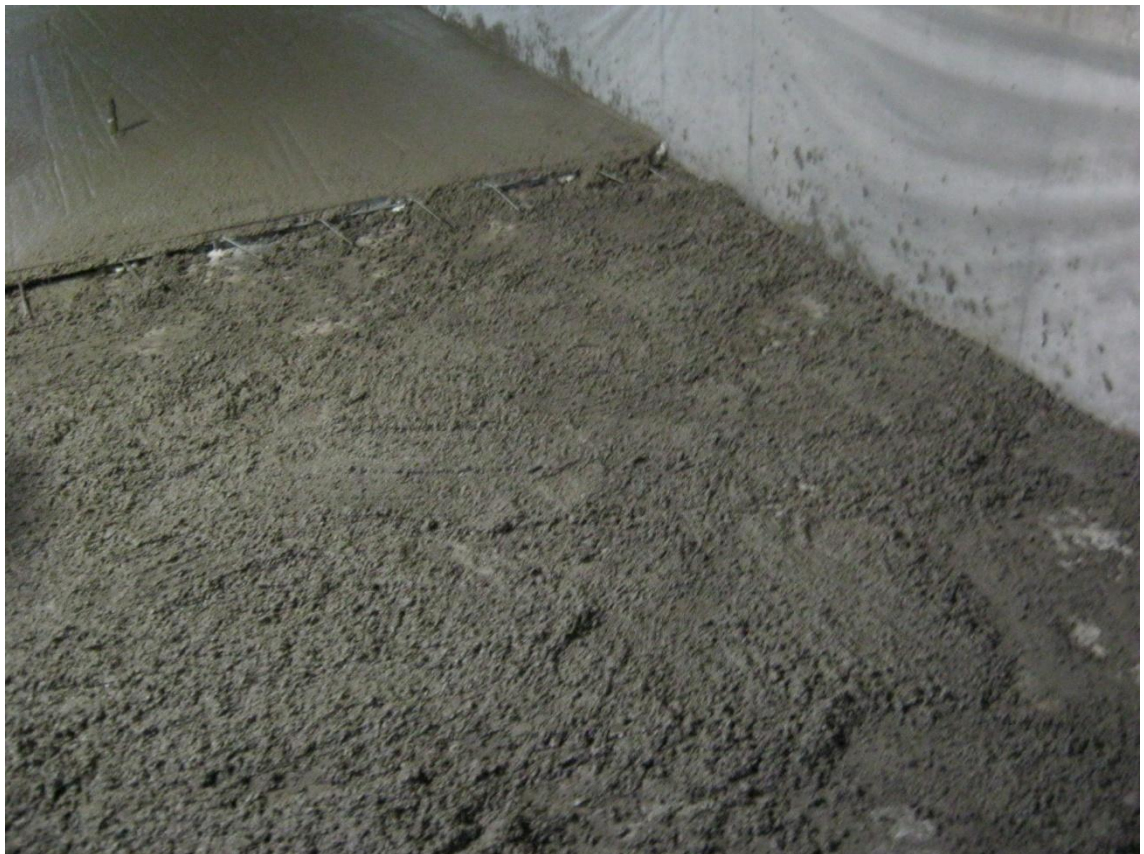
Kuva 13. Pintabetonilattian tartuntaharjaus.
