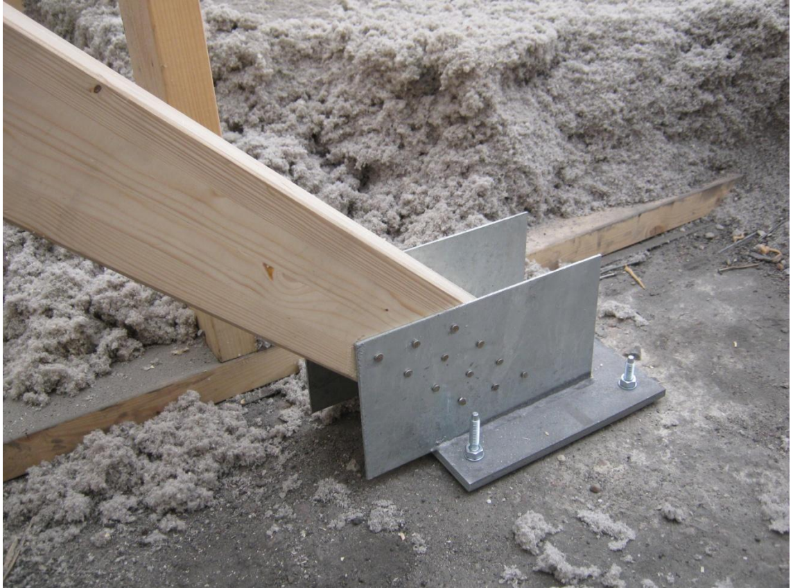
Kuva 17. Vinotuen kiinnitys holviin.
