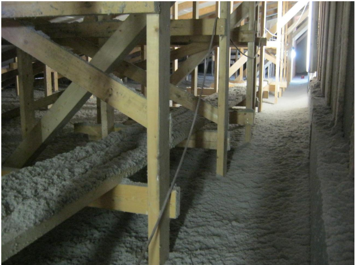
Kuva 29. Vanhan puhallusvillaeristeen takaisin puhallus.
