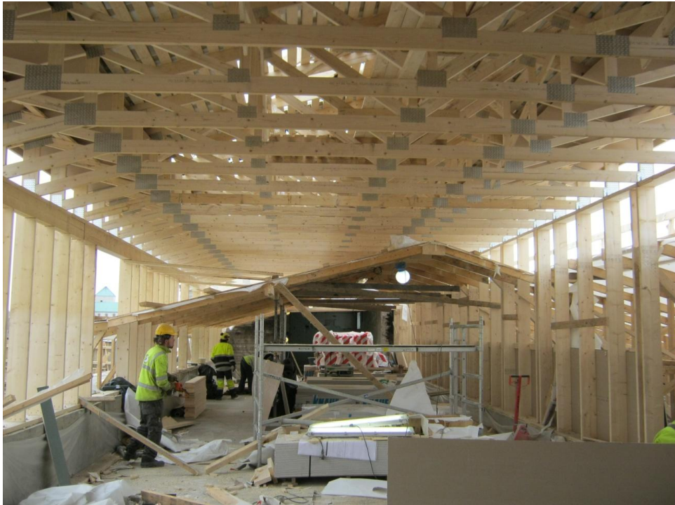
Kuva 26. Vanhat vesikattorakenteet purettiin uuden vesikaton alla.
