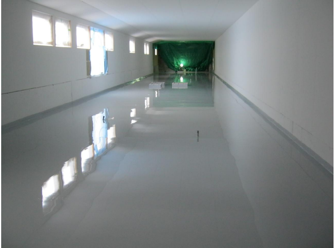
Kuva 31. Polyuretaanipinnoitettu lattia.
