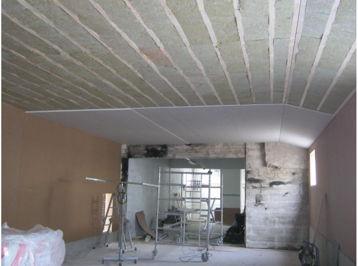
Kuva 30. Katon levytys.
