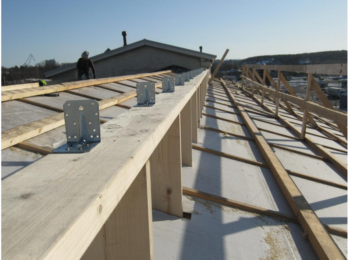
Kuva 6. Vesikatonkaton suojakaiteet.
