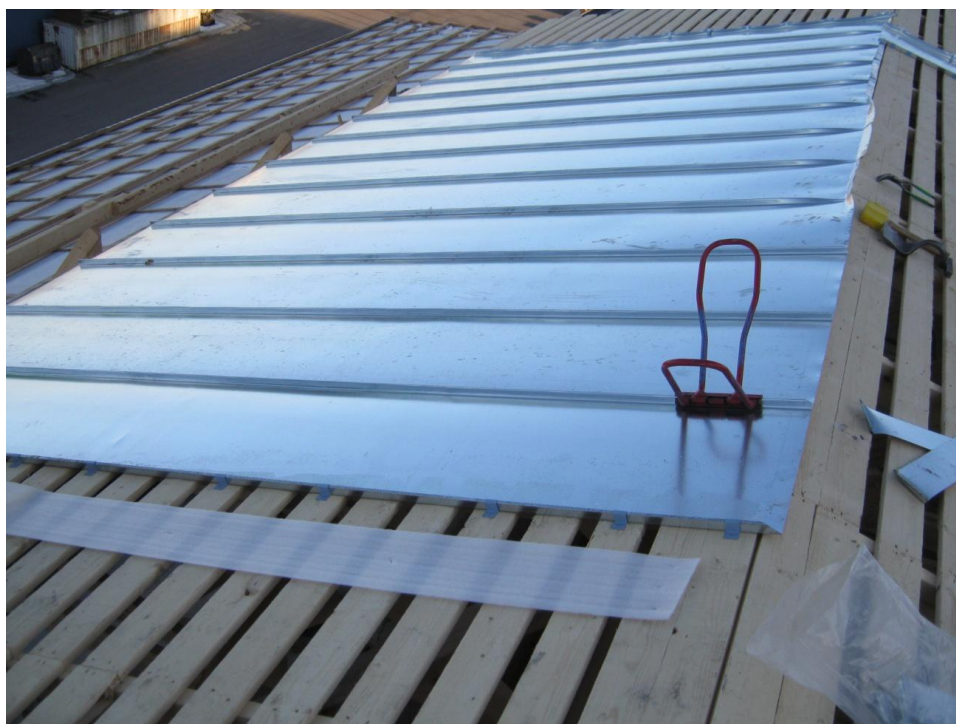
Kuva 25. Saumatun peltikatteen asennus. Äänenvaimennuskaista edessä.
