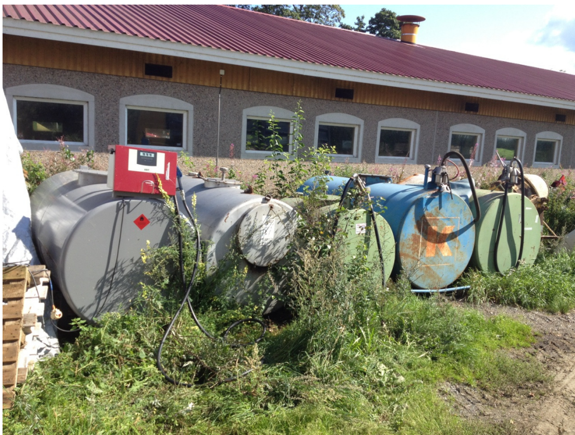
Kuva 8 Polttoöljysäiliöiden virheellinen säilytys.
