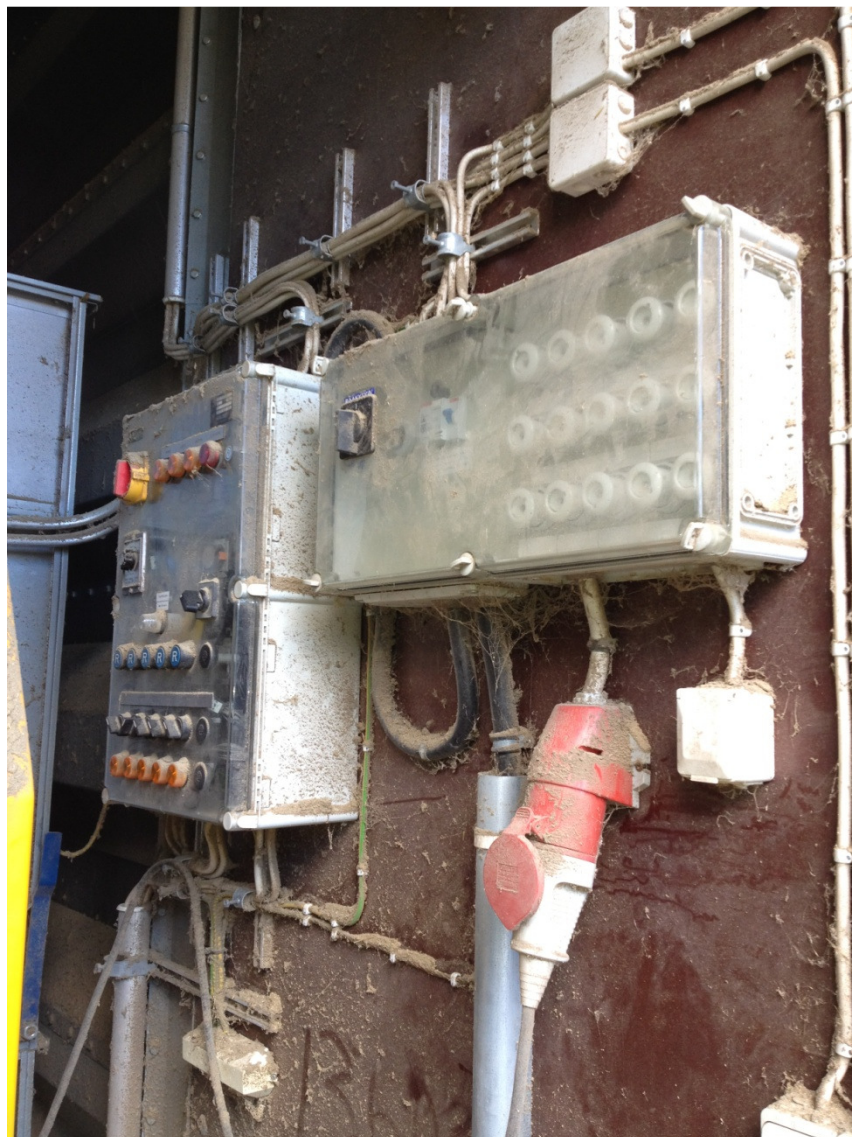
Kuva 6. Tyypillinen peruskorjatun ja laajennetun navetan sähkötaulu. (Simo Karjalainen)
