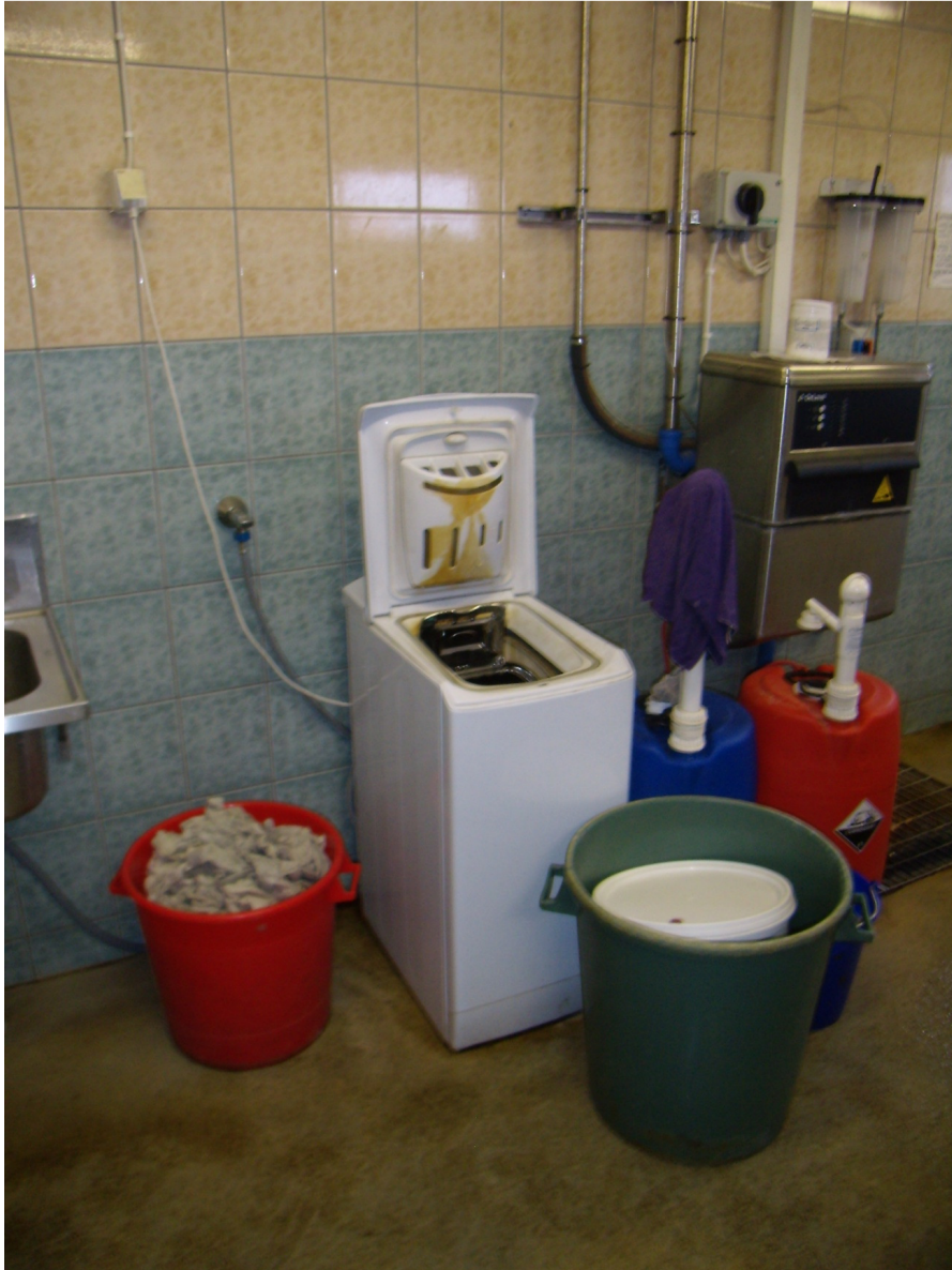
Kuva 4. Maituhuoneen yhteydessä oleva pesukone työvaatteiden pesua varten aiheuttaa tulipaloriskin, mikäli se jätetään pyörimään valvomatta.
