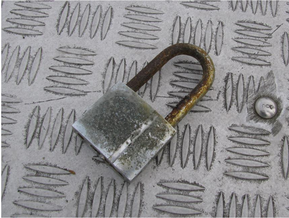
KUVA 12. Korroosiota Moisionpellon pumppaamon munalukossa (Hiltunen 2012).
