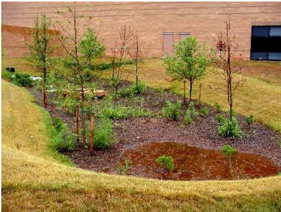
Kuva 21. Kasvillisuuden peittämä imeytyspainanne (Bioretention Installations in Prince George's County, MD.)
