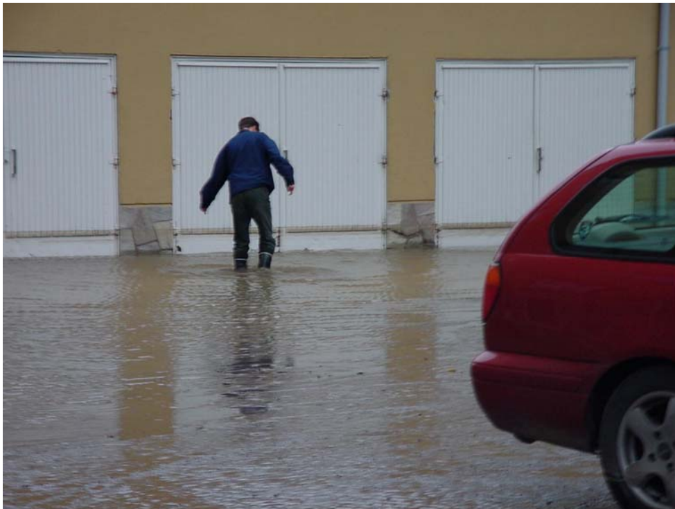
Kuva 27. Vesijohtovuodon seurauksia Kalevassa 6.9.2000 (Tampereen Vesi)
