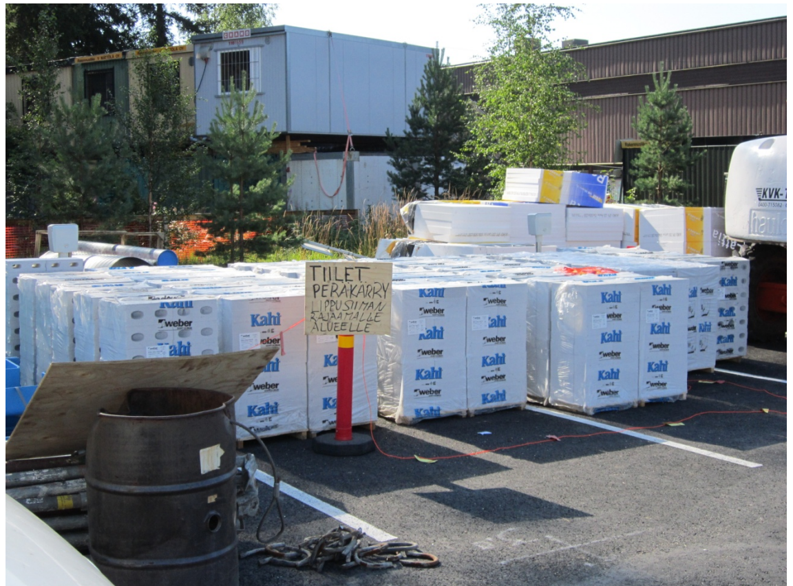
Kuva 9. Rakennusliike V.Mättölä'n työmaa 516 Mikkelin jäähallin laajennus
