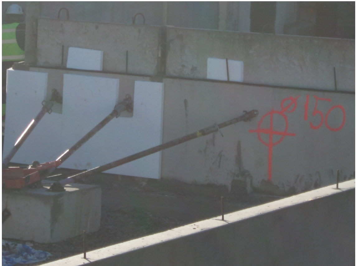
Kuva 6. Kuva Rakennusliike V.Mättölä Oyn työmaalta Myrskylästä. Kuvassa reiän paikka on osoitettu ristillä, ja vieressä lukee reiän halkaisijan mitta.
