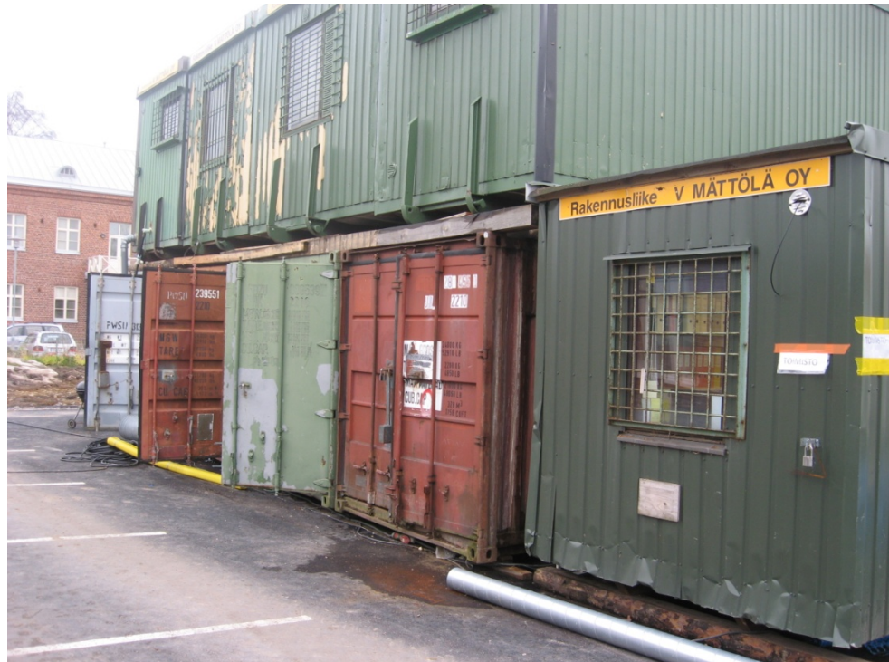
Kuva 10. Rakennusliike V.Mättölään työmaan varasto- ja sosiaalityötilat Orimattilassa
