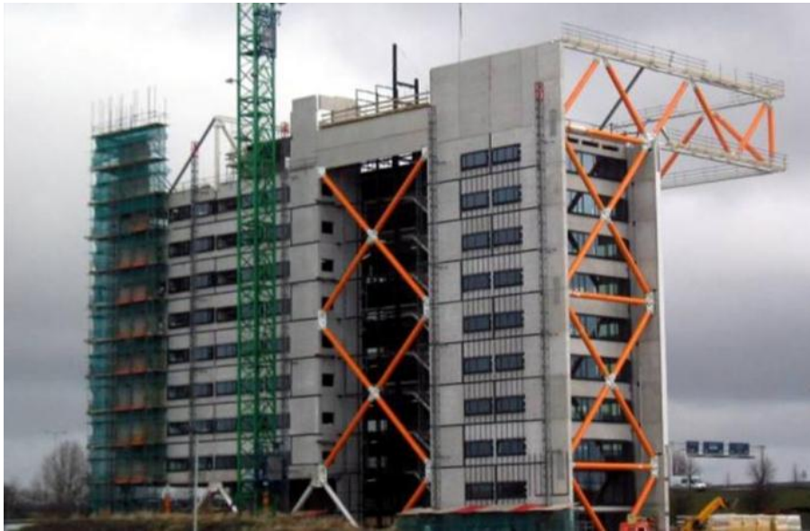
Kuva 8 Erillinen jäykistysristikkorakenne (Elementtisuunnittelu)
