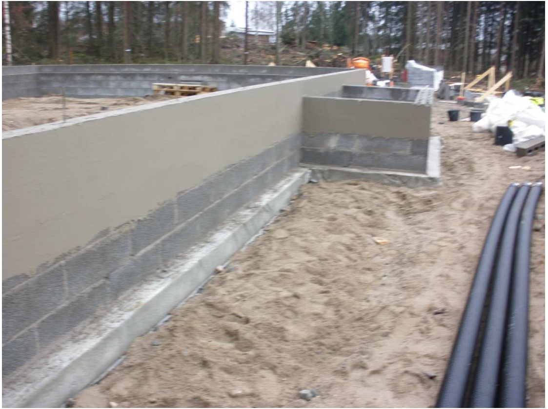
Kuva 3. Perustukset. Kuva Harri Lyytinen 2012.
