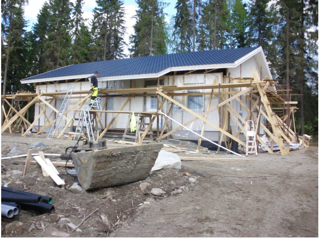
Kuva 6. Peltikatto asennettuna. Kuva Harri Lyytinen 2012.
