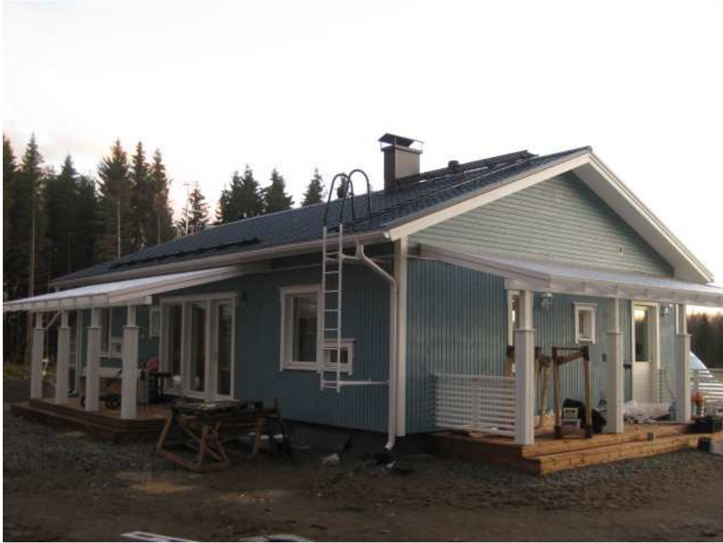
Kuva 13. Rakennus ulkopuolelta. Kuva Harri Lytinen 2012.
