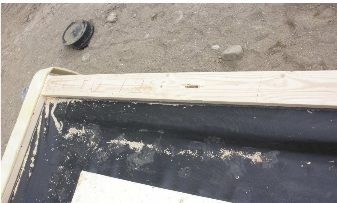
Kuva 5. Alajuoksun asennus ja elementtien numerointi. Kuva Harri Lyytinen 2012.
