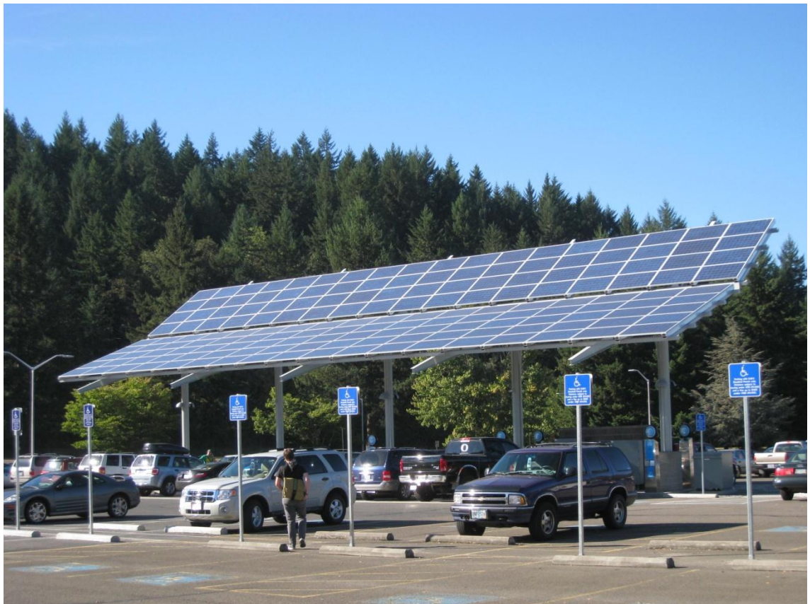
Kuva 37. Aurinkopaneeleista rakennettu autokatos.
