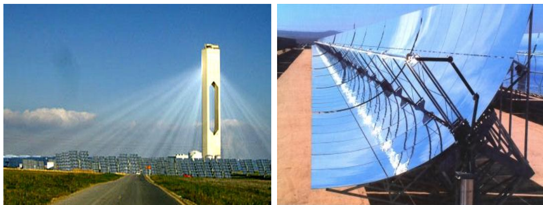
Kuva 33. Keskittäviä CSP-aurinkosähköjärjestelmiä – torni- ja kourutyypinen.
