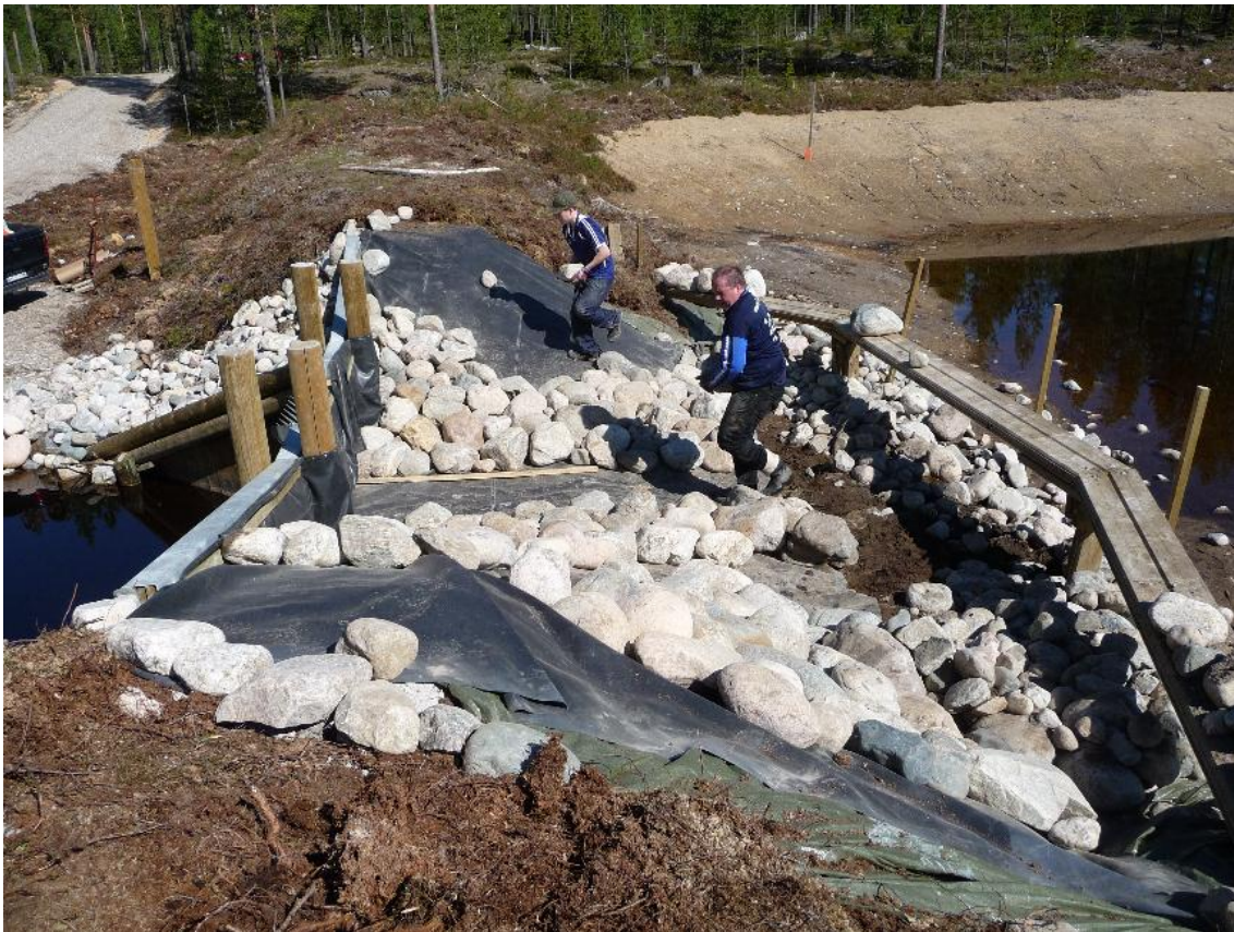
KUVA 24. Yläpadon vuoto korjattiin betonilla ja allaskumilla (Rasimus 2012)
