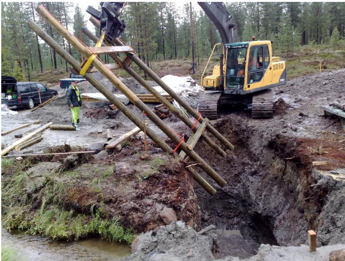
KUVA 12. Yläpadon tukipilareiden asennus (Rasimus 2011)
