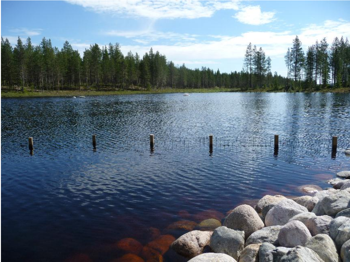
KUVA 19. Padon yläpuolelle rakennettu roskien padolle pääsyn estävä suoja-verkko (Rasimus 2012)
