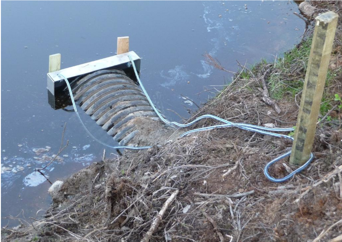
KUVA 17. Padon rakennustyön mahdollistavat rummut suljettiin ruostumattomasta teräksestä tehdyillä levyillä (Rasimus 2011)
