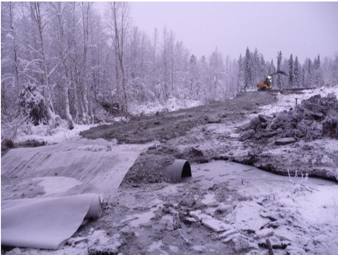
KUVA 9. Maan jäädyttyä aloitettu alapadon huoltotien rakennustyö (Rasimus 2010)
