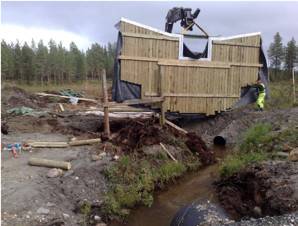
KUVA 13. Puurakenteisen patoseinän paikalleen nostaminen (Rasimus 2011)
