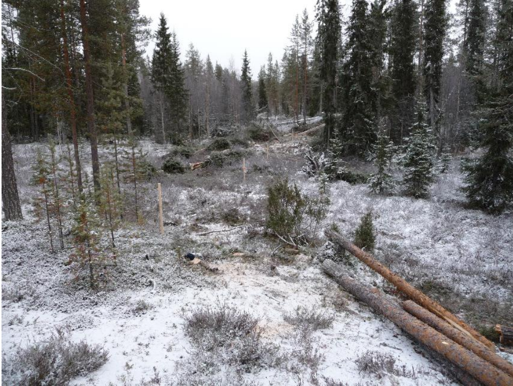
KUVA 7. Yläpadon huoltotie rakennustöiden alkuvaiheessa (Rasimus 2010)
