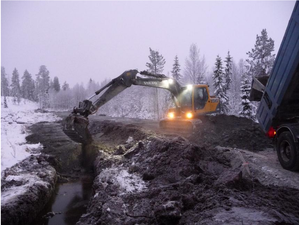
KUVA 10. Alapadon patopenkereen sydämen rakentaminen (Rasimus 2010)
