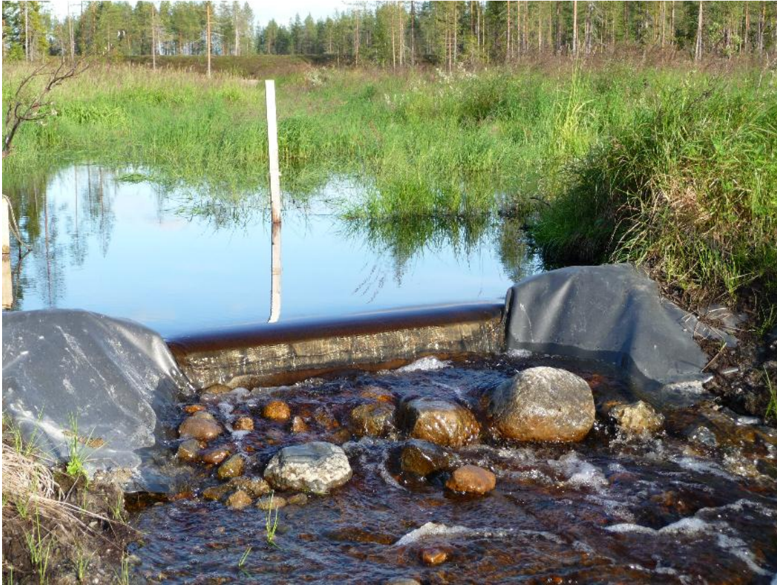
KUVA 23. Korjattu välipadon ylivirtausaukko (Rasimus 2012)
