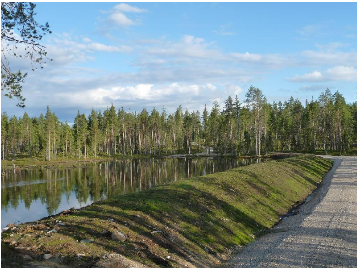
KUVA 3. Kosteikkoalue 2, patopenger ja huoltotie (Rasimus 2012)
