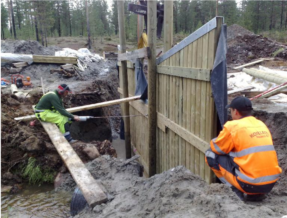
KUVA 14. Patoseinän kiinnittäminen tukipilareihin (Rasimus 2011)
