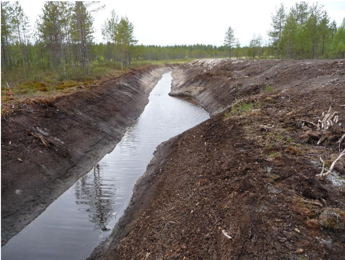
KUVA 22. Valtaojaan kaivettu hiekkasieppari (Rasimus 2012)
