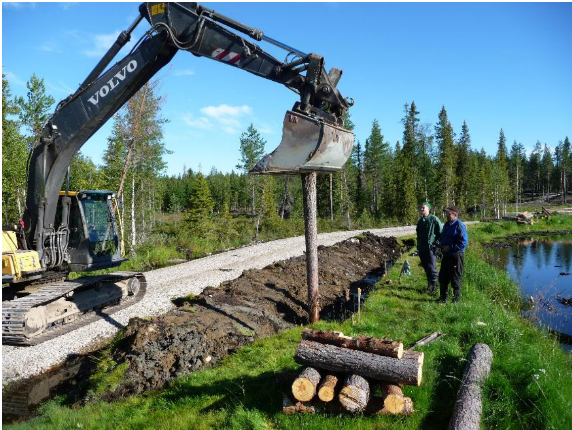
KUVA 26. Puupaalut juntattiin maahan kaivinkoneella (Rasimus 2011)
