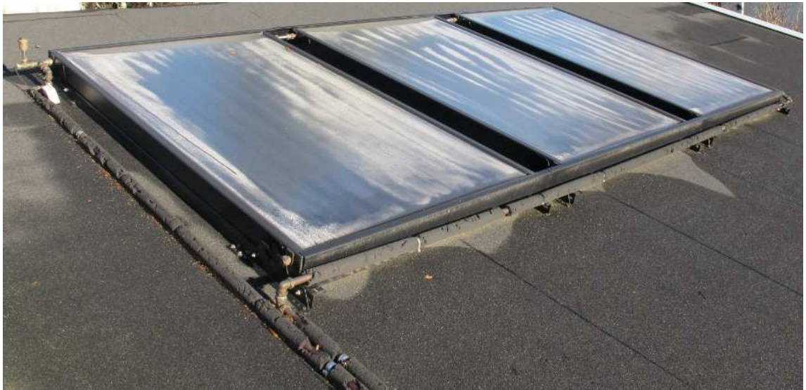
Kuva 17. Tasokeräimet talon katolla.
