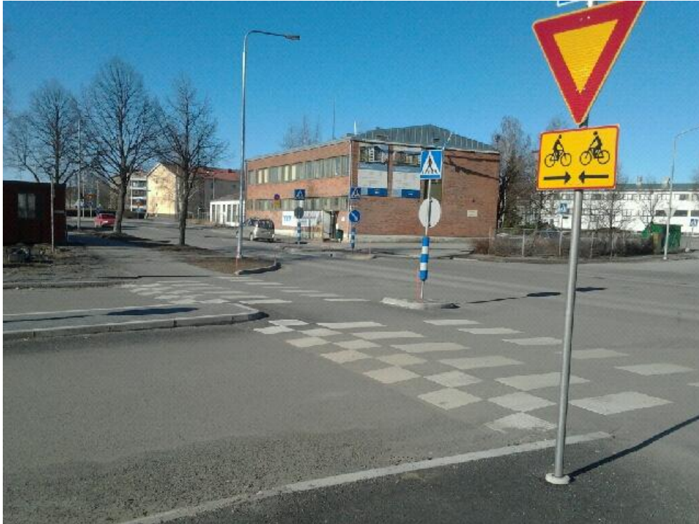
Kuva 11. Pyörätien jatke liittymässä, turvallisuutta on parannettu keskisaarekkeella, hidasteella ja kaksisuuntaisen pyöräliikenteen lisäkilvellä (8)
