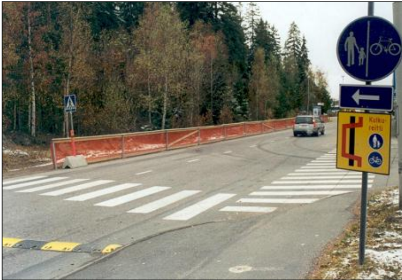
KUVA 6. Onnistunut kevyen liikenteen opastus työmaan kohdalla (Kadulla tehtävät työt – lupamenettelyn kehittäminen. 2002)
