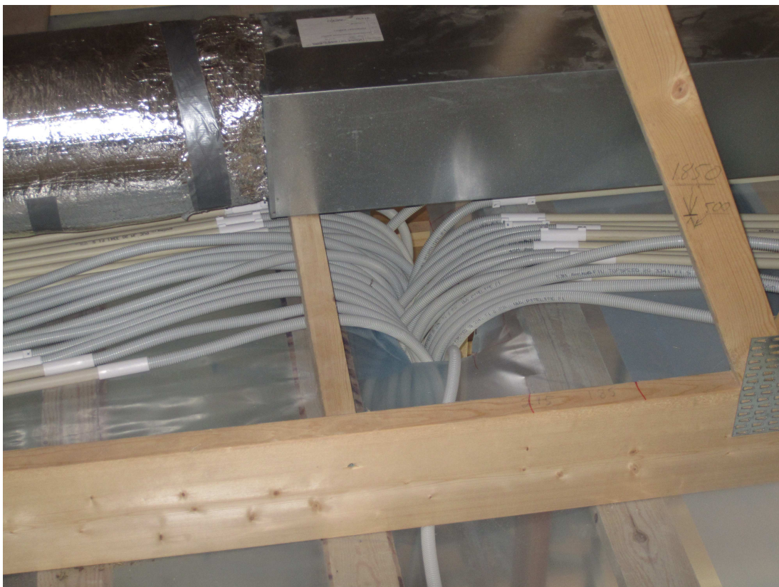
Ryhmäkeskuksen putkitus katolta väliseinään
