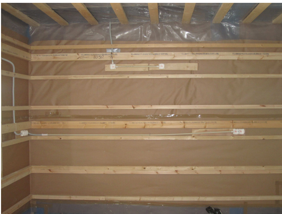
Keittiön seinä, pistorasiaryhmiä
