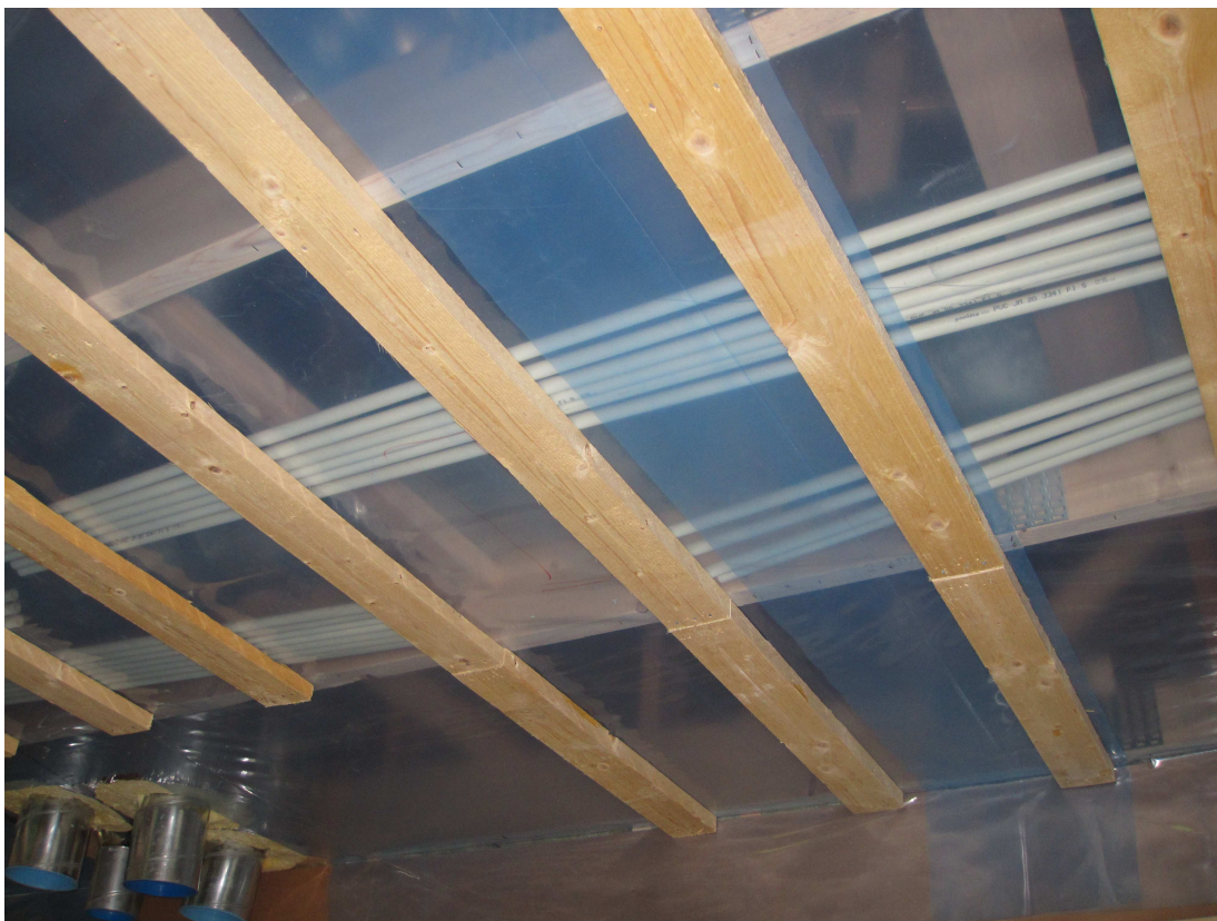
JM20 asennuksia kattotuolien välissä
