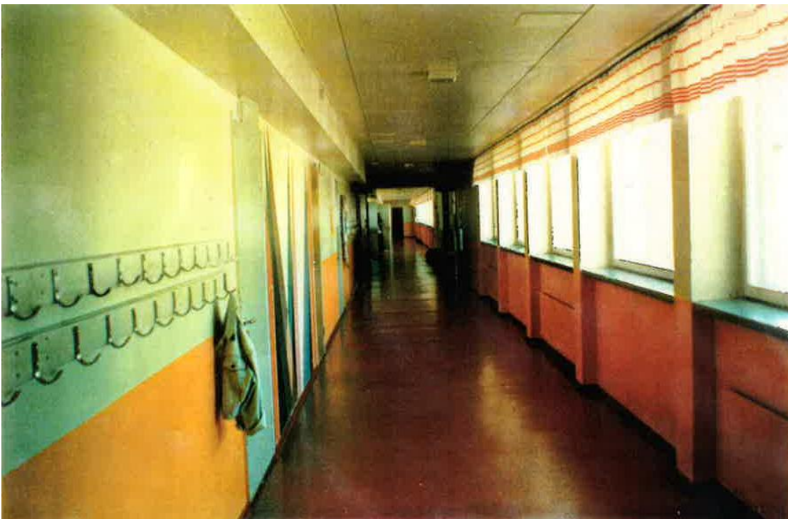
Kuva 4. Varpaisjärven koulukeskus. Yläasteen käytävä ennen peruskorjausta. (Hankesuunnitelma.)
