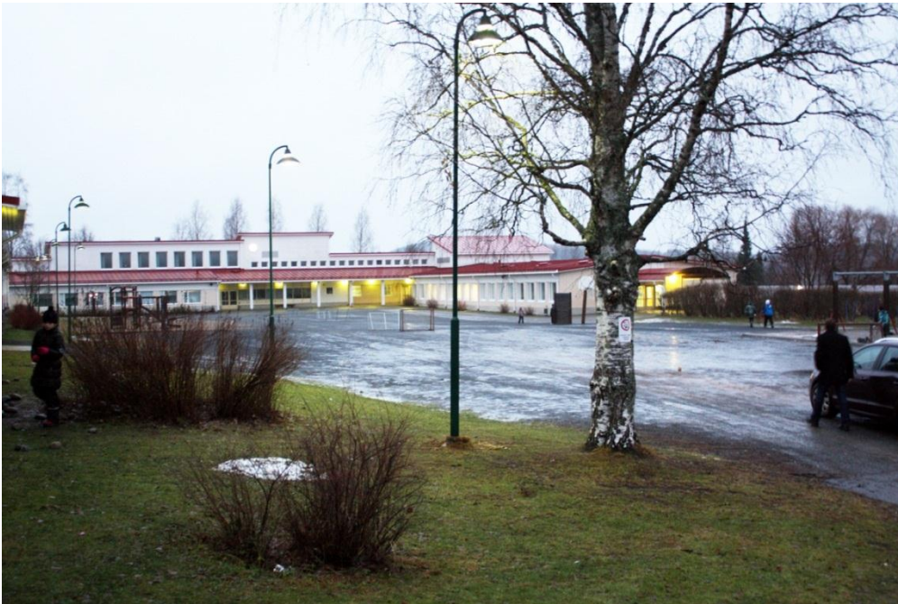
Kuva 11. Varpaisjärven koulukeskus. Ala-aste korjauksen jälkeen. Valokuva Anssi Huusko 2012.
