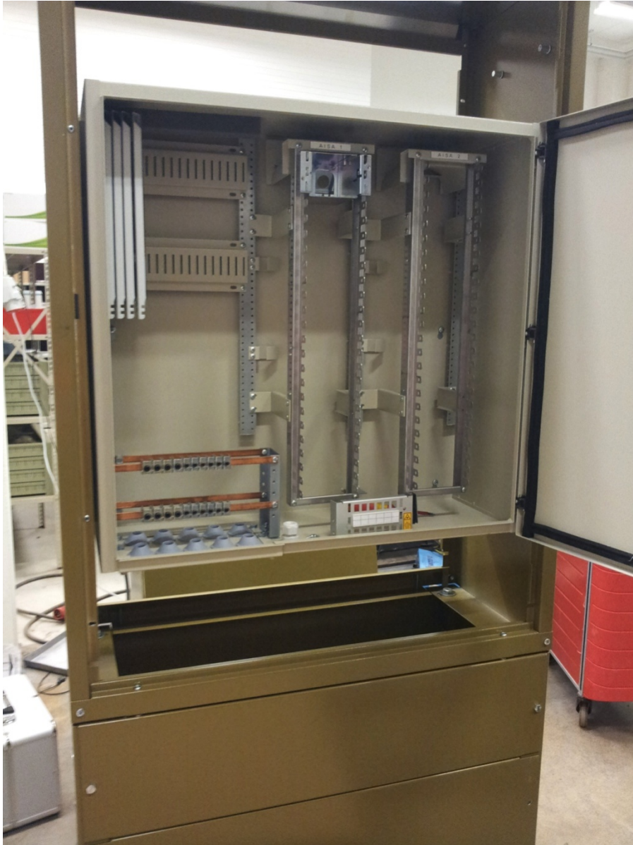
KUVIO 7. Ristikytkentäkaappi
