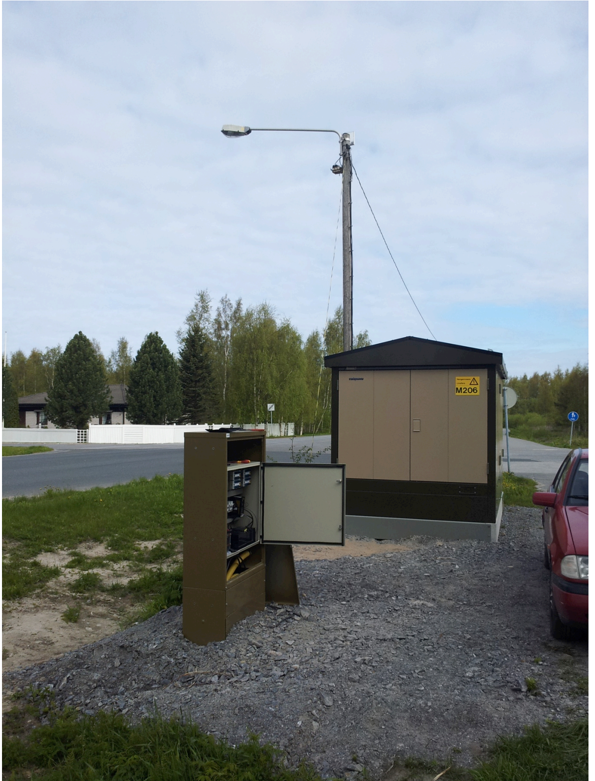
KUVIO 5. Aktiivilaitekaappi ja päätelaitte
