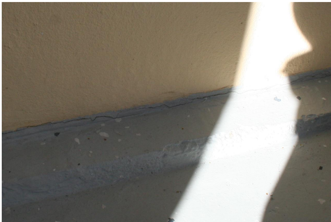
Kuva 9. Haurastunut elementtisauma
