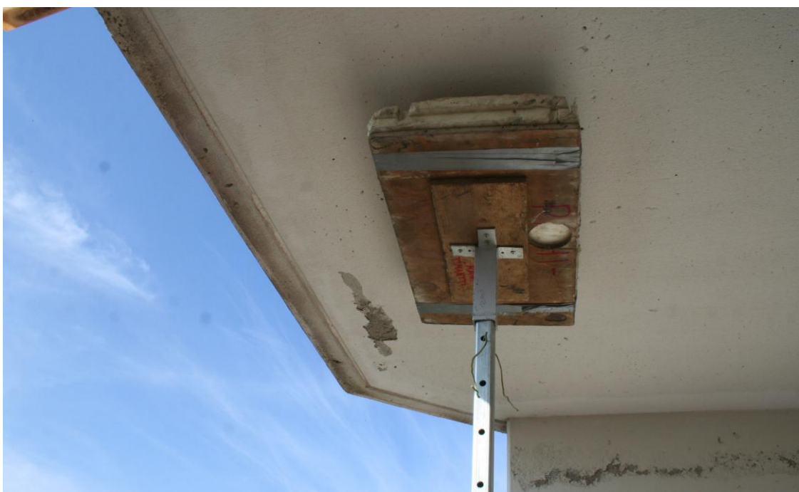
Kuva 21. Porauksen alapuolinen tuenta.
