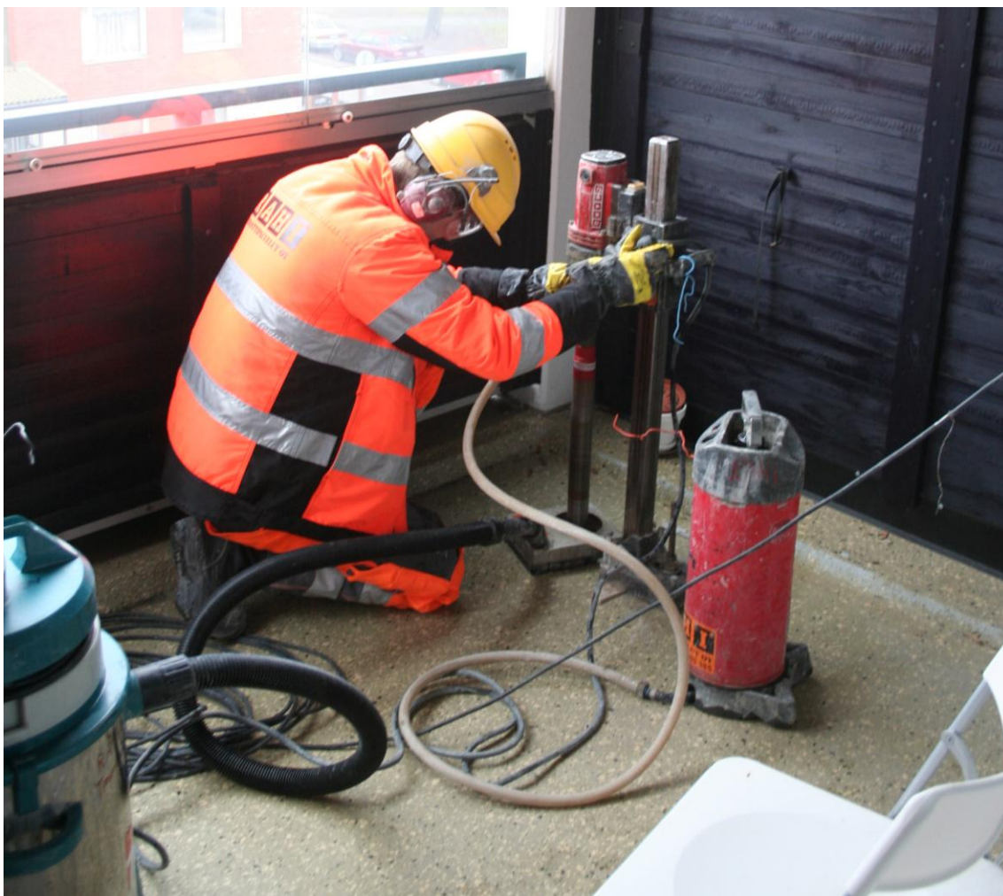
Kuva 20. Näytteenottoporaus urakoitsijan toimesta eri kohteessa
