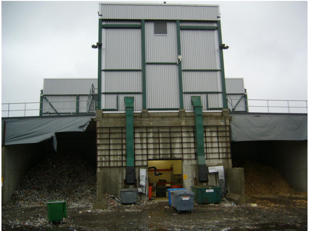
KUVIO 8. Kujalan jätekeskuksen murskauslaitoksen tuotesiilot ja työtila
