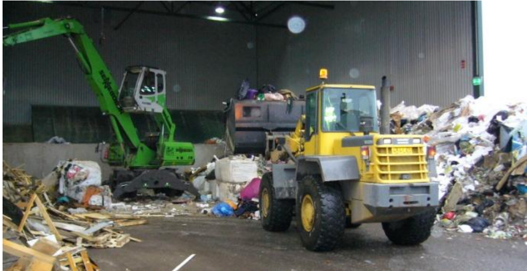
KUVIO 9. Käsiteltävät jätekuormat siirrettiin välivarastosta murskauslaitoksen syöttökoneelle kauhakuormaajalla
