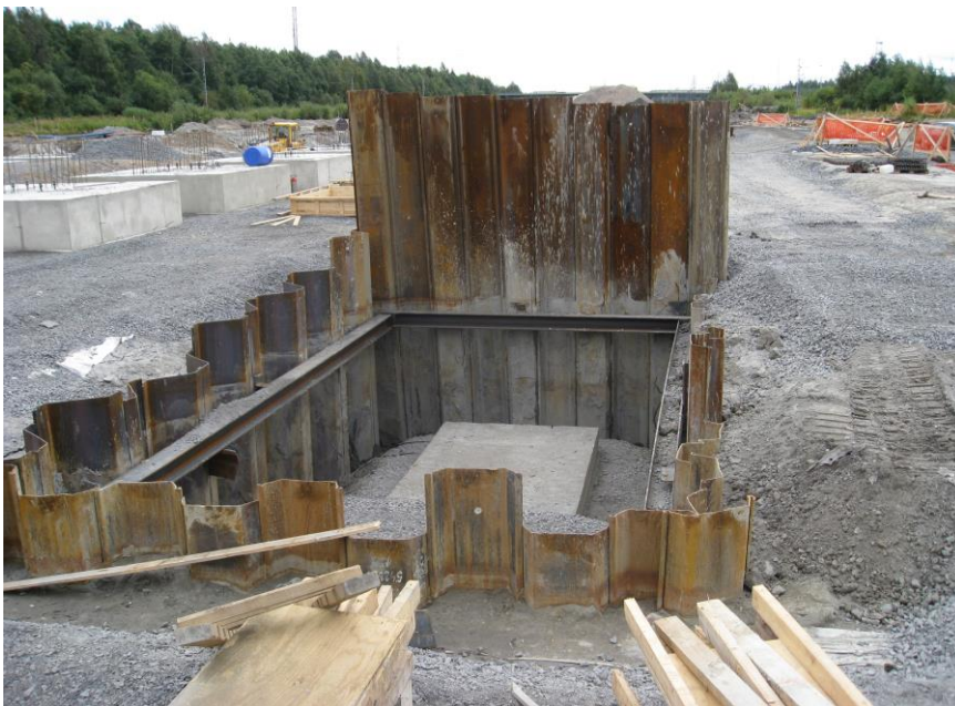
KUVA 4. Ponttiseinät tuettuina teräspalkeilla sekä pohjalle valettu painolaatta
