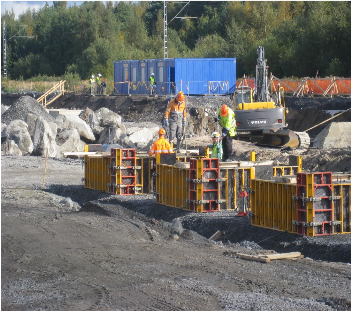
KUVA 9. Betonivalun vibraus käynnissä
