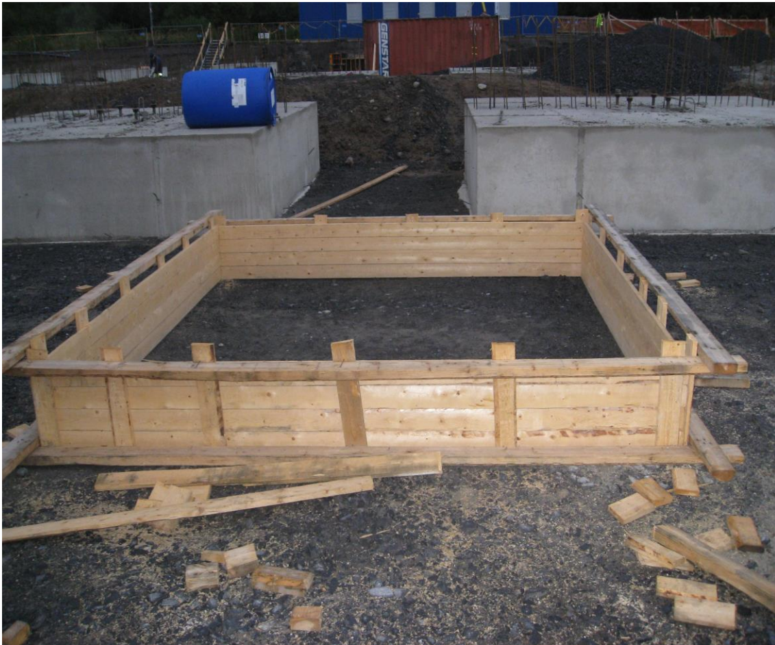
KUVA 7. Kappaletavarasta rakennettu pilarianturamuotti
