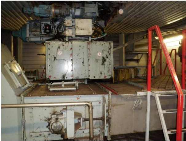
Kuvio 24. Kattilasiilon alaosa, ruuvipurkaimen kääntölaitteet ja kolakuljetin.
