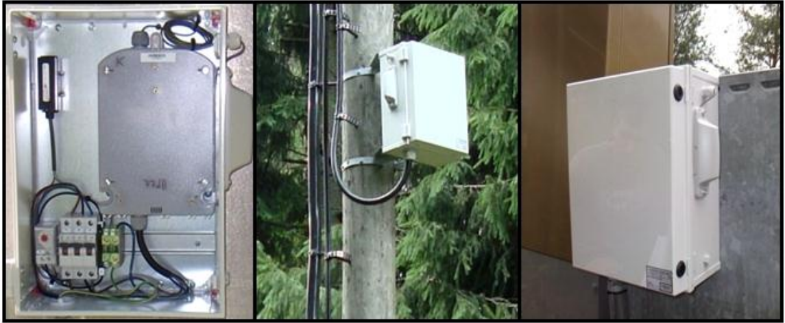
Kuva 8. Fibox-kotelo (vas.) ja keskittimen pylväs- (kesk.) sekä maajakokaappiasennus (oik.) [19]
