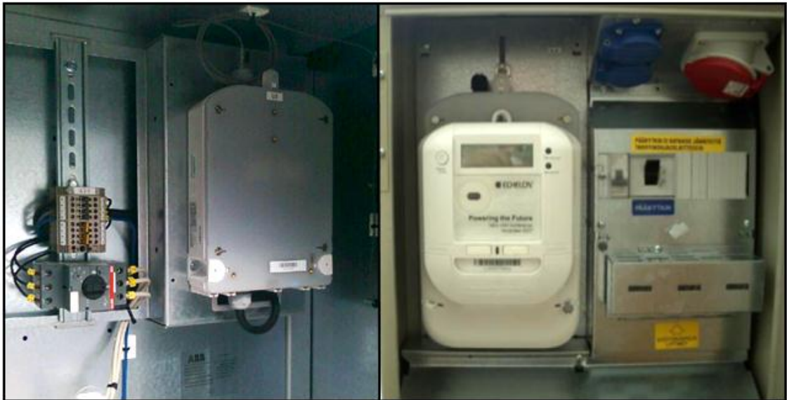
Kuva 7. Keskittimen maamuuntamo- (vas.) [19] ja reppuasennus (oik.) [17, s. 10]
