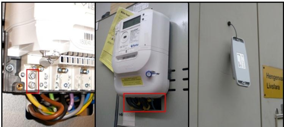
Kuva 9. Asennustarkastuksissa havaittuja mekaanisia poikkeamia
