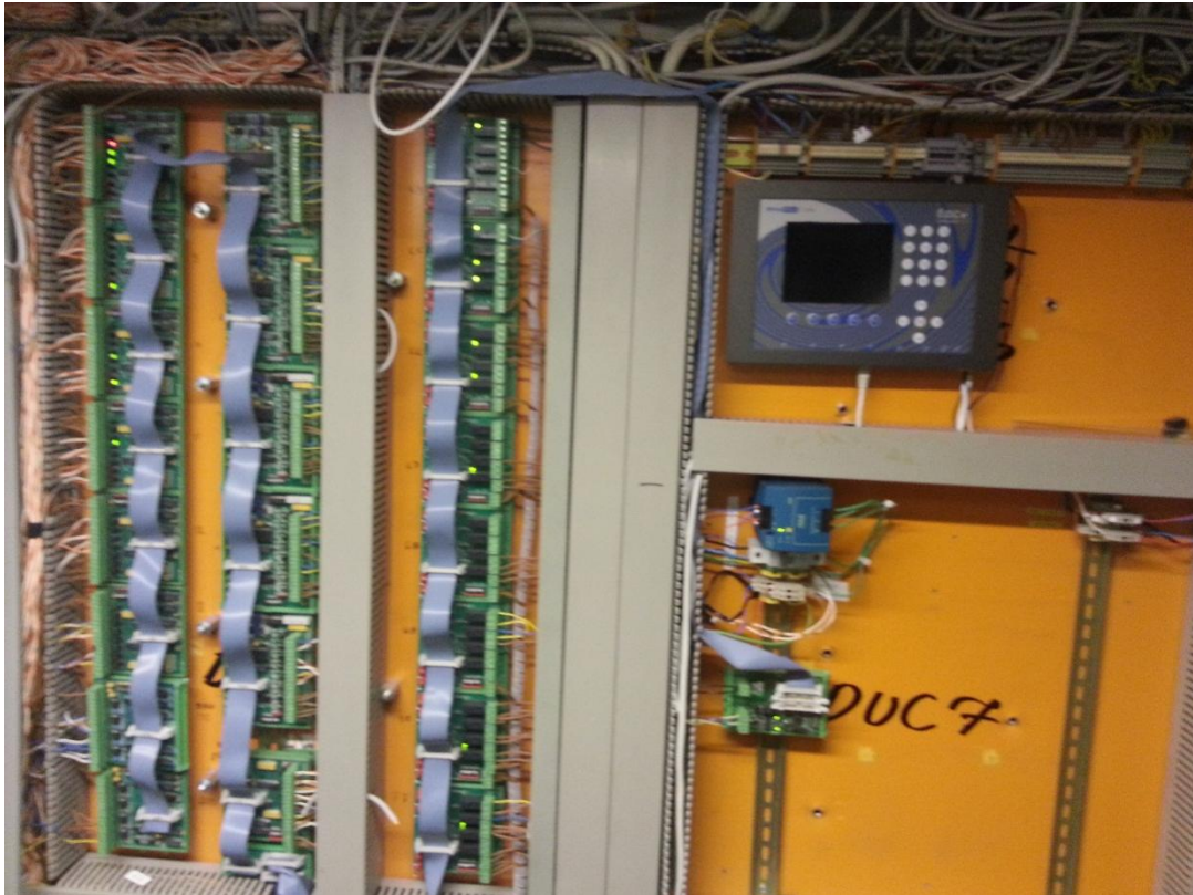
Kuva 8: Ala-asema 2:n sisältö ja uusi CPU-yksikkö IC1000.
