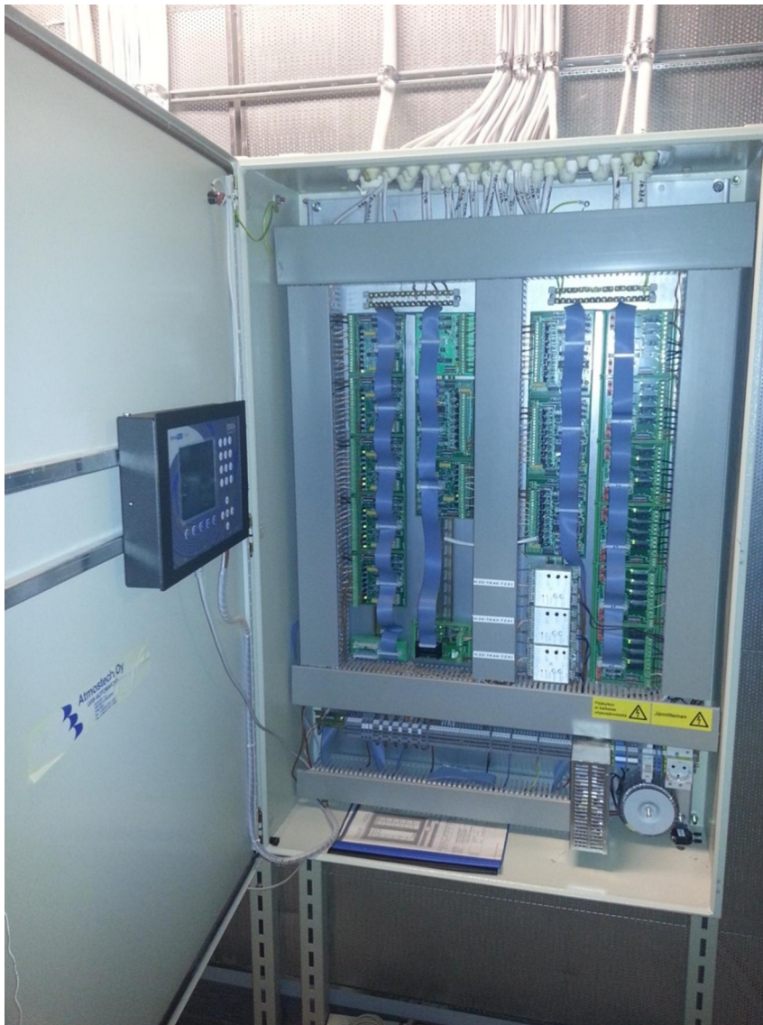
Kuva 13: Ala-aseman 22:n sisältö ja uusittu CPU-yksikkö IC1000.
