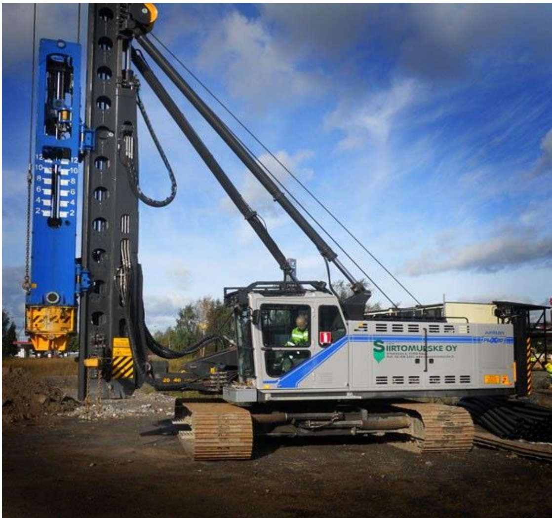
Kuva 5. Betonipaalutus kone. (Siirtomurskeen www-sivut .)
