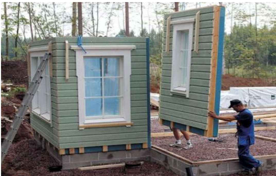
Kuva 17. Suurelementtien asennusta (Suomelan www-sivut)
