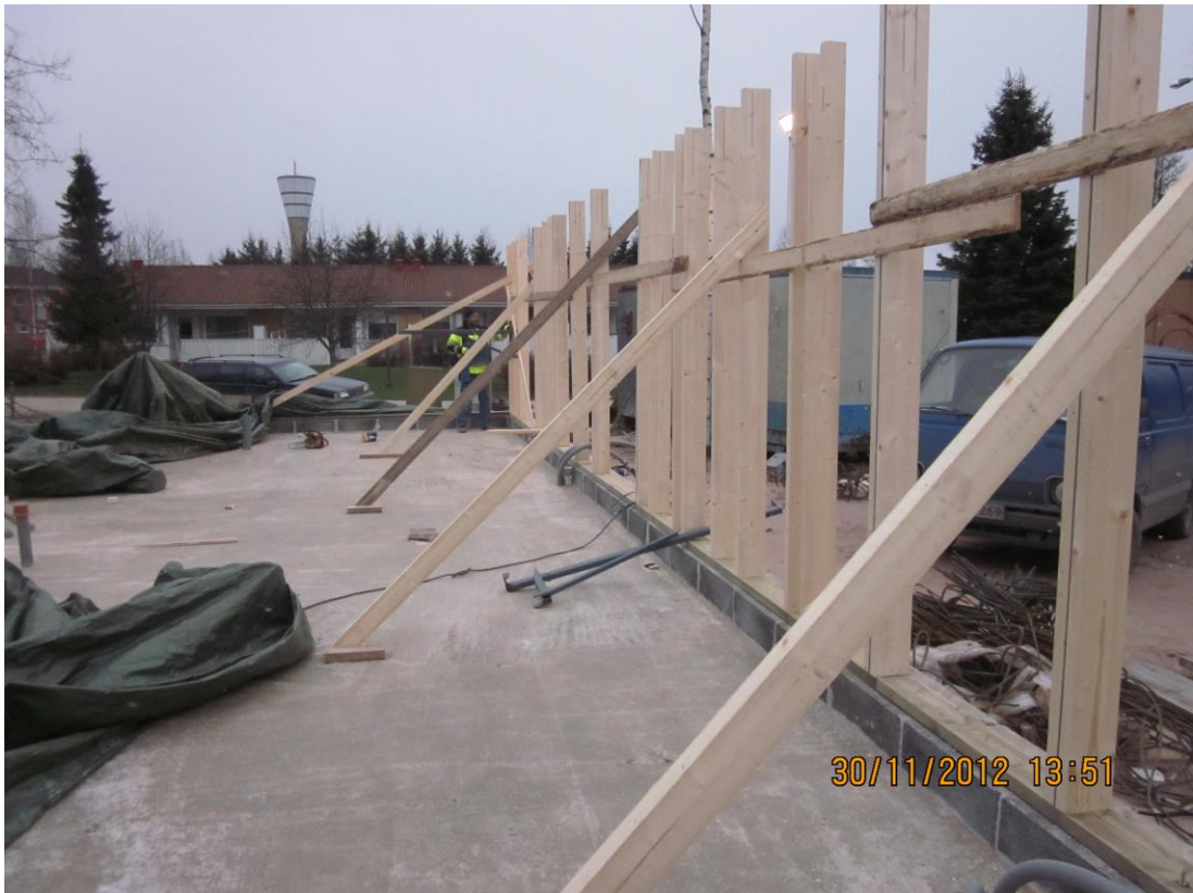
Kuva 14. Rungon asennustyö käynnissä
