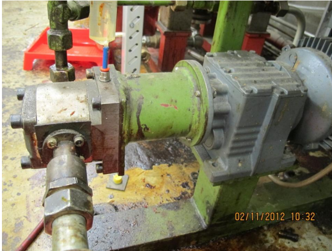
KUVIO 14: Polyuretaanipinnoituskopin kylmävalutankin pumppu
