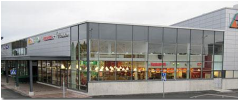
Kuva 10. Kauppakeskukseen valmistetut ikkunat.
