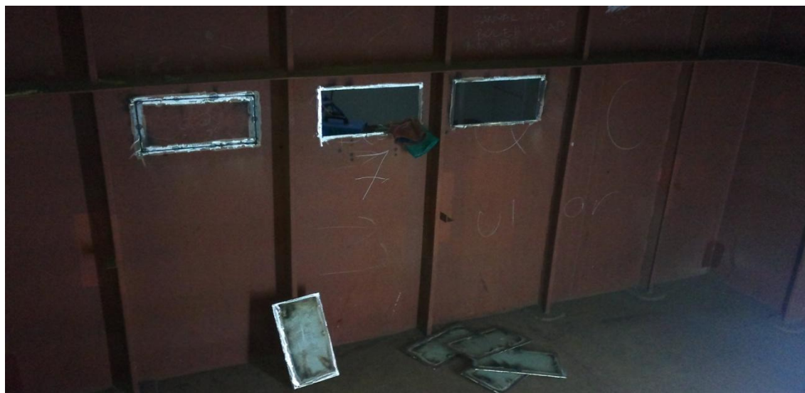
Kuva 15. Väärään laipioon poltetut aukot hitsataan umpeen.
