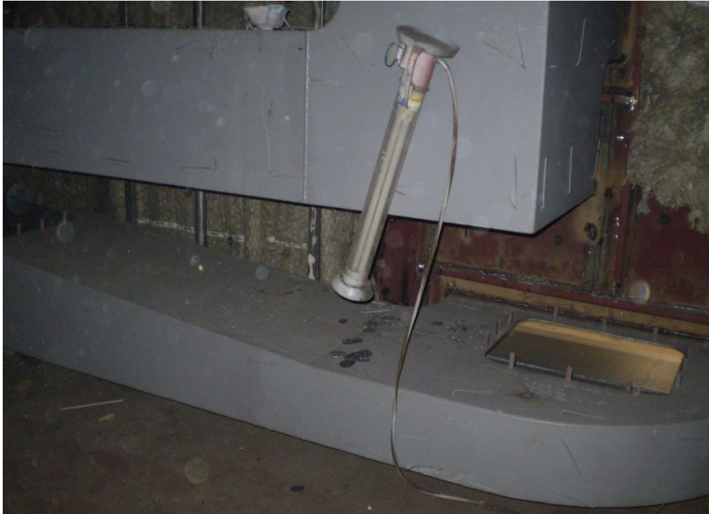
Kuva 8. Villapiikit asennettu oikeaoppisesti kanaviin.
