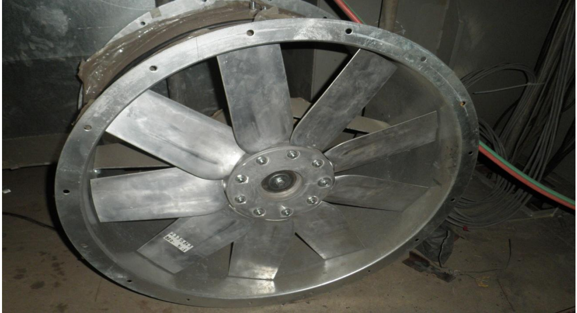
Kuva 13. Poistoilmapuhallin Systemair.
