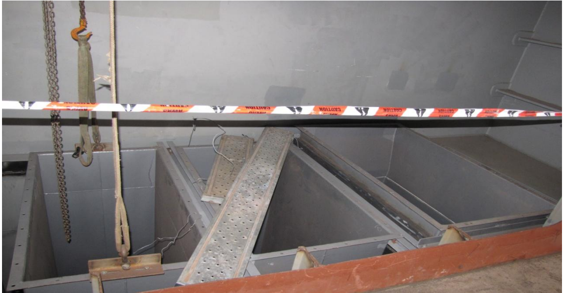
Kuva 14. Nostotalja kanavakiinnikkeineen.
