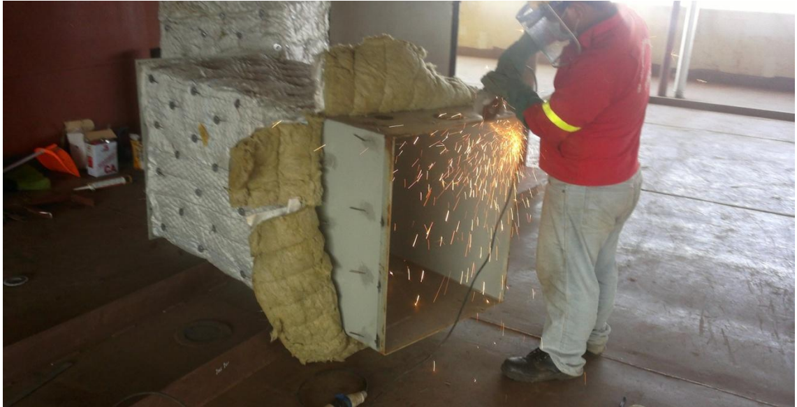
Kuva 18. Etukäteen eristettyä kanavaa valmistellaan asennukseen.
