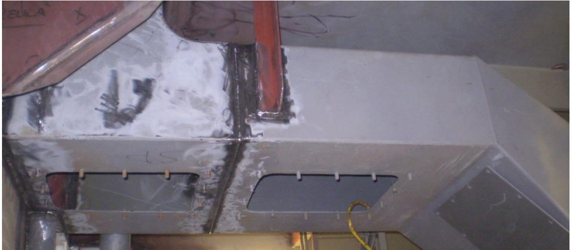
Kuva 6. Hitsattu liitos paksulevykanavassa.
