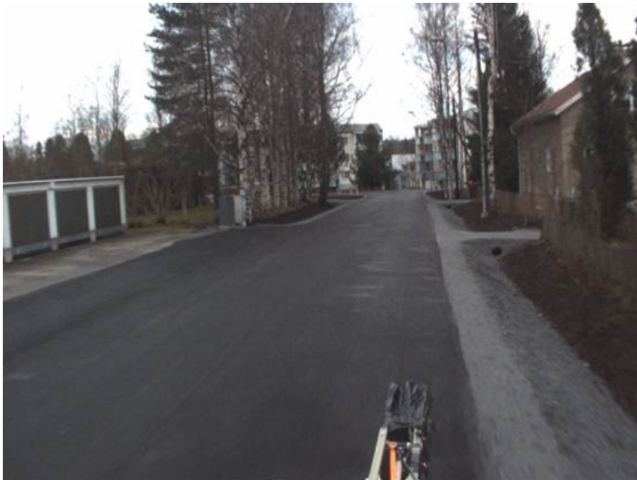
Kuva 19 Kadun still-kuva laadunvarmistusmittausten yhteydessä
