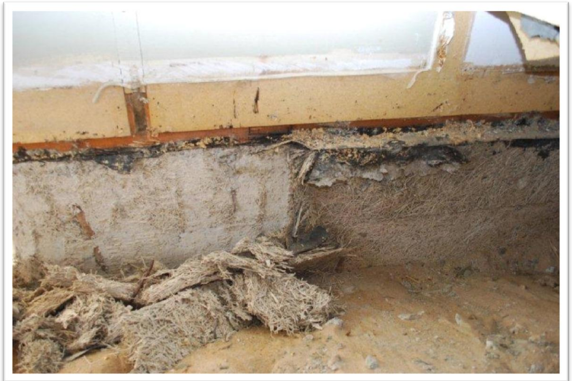
Kuva 2. Toja-levy sokkelin sisäpuolella (Ympäristöministeriö 2013).
