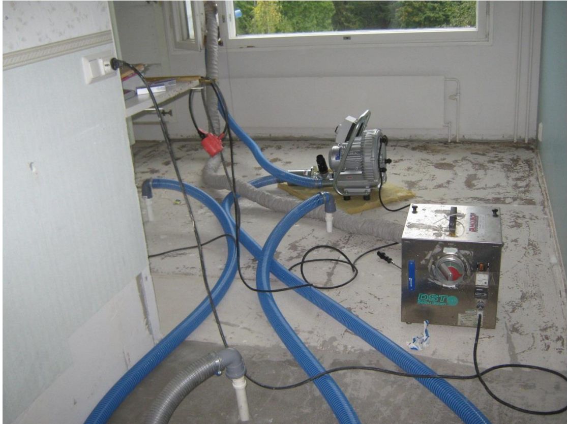
KUVA 7. Eristetilan imukuivaus
