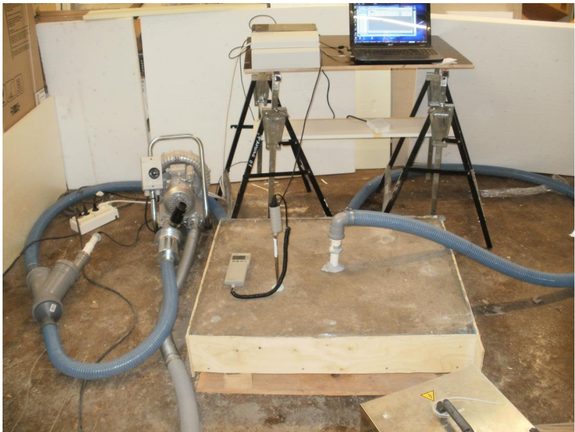
KUVA 19. Testilattian imukuivaus ja imukuivauksen seuranta
