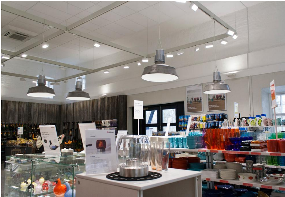
KUVA 22. LED-tekniikalla toteutettu Iittala/Fiskarsin outlet-myymälä. /1/
