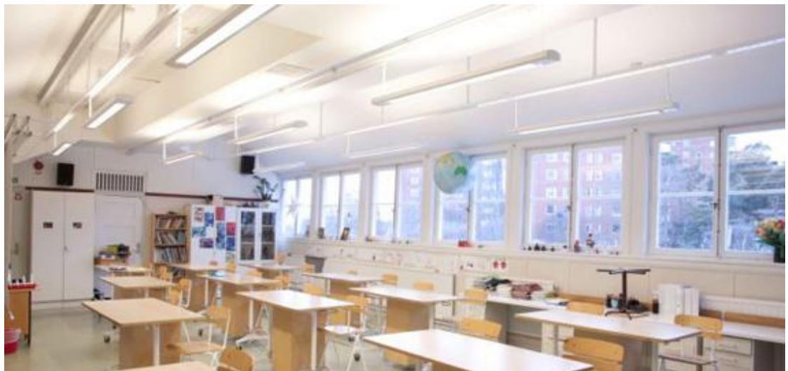
KUVA 25. LED-valoputkilla toteutettu luokkahuoneen valaistus /11/
