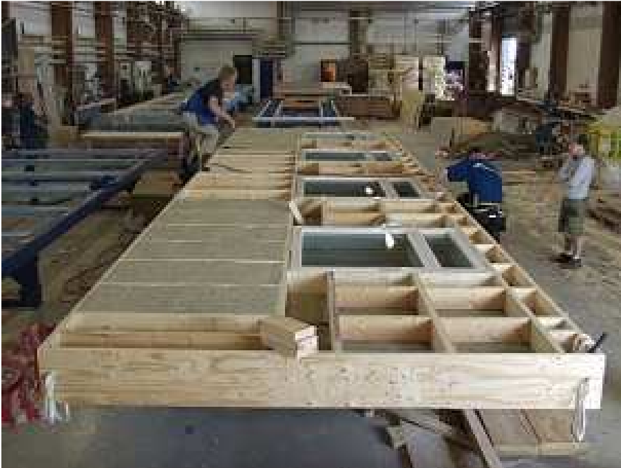
Kuva 5. Lämpöeristeiden asentaminen elementtiin.
