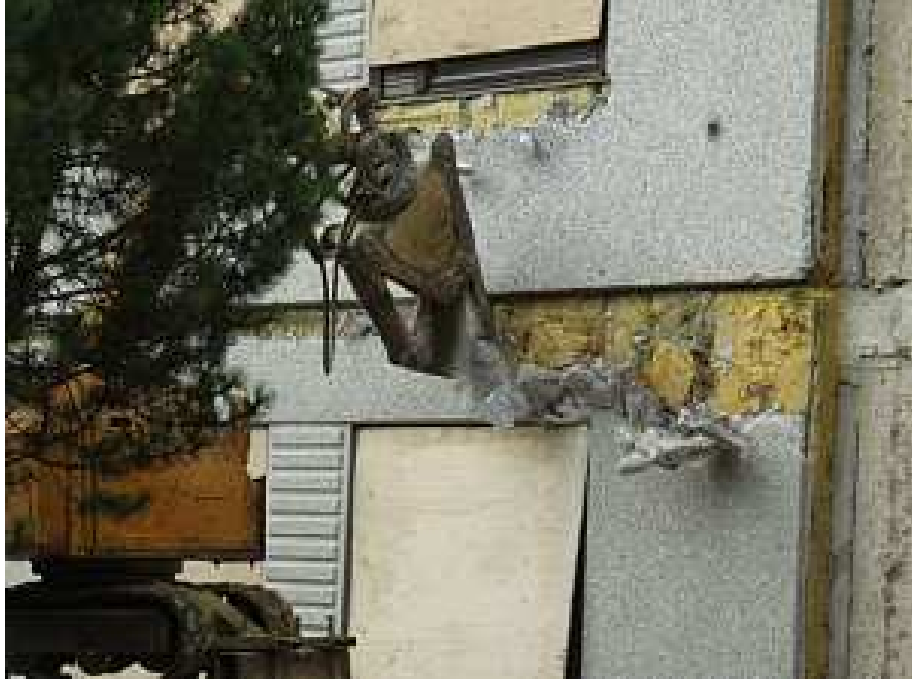
Kuva 15. Vanhan seinärakenteen purkaminen.
