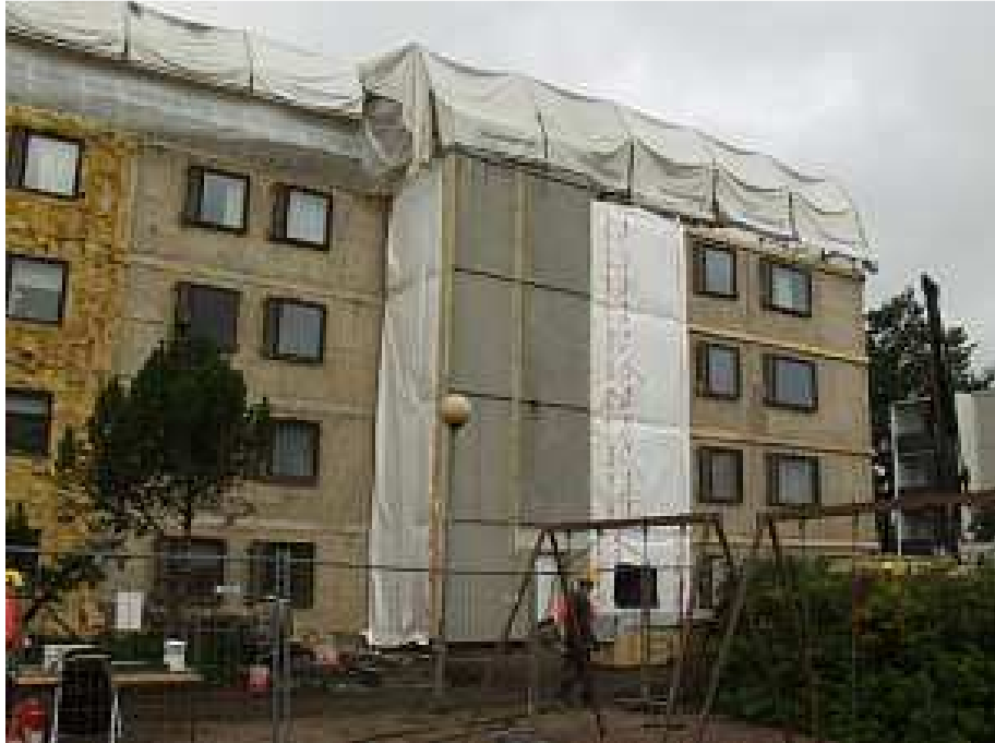
Kuva 19. Ensimmäiset elementit asennettuina paikalleen.
