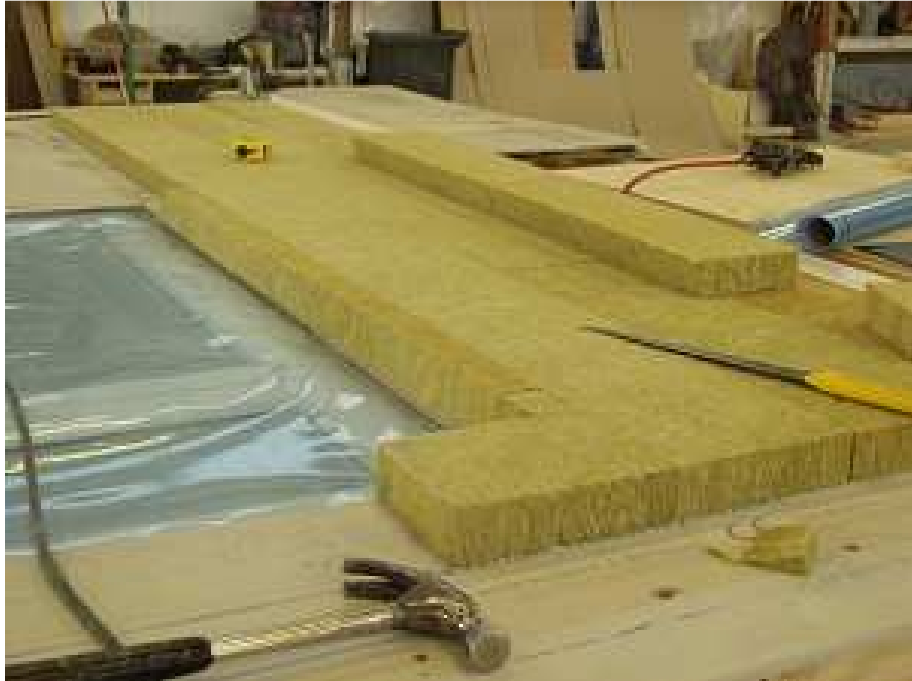
Kuva 7. Lamellikivivillojen asentaminen elementtiin.
