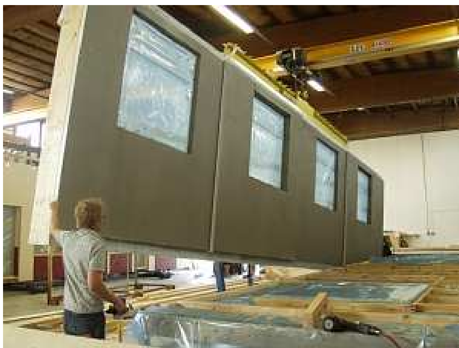
Kuva 10. Valmiin elementin siirtäminen vakkiiin.
