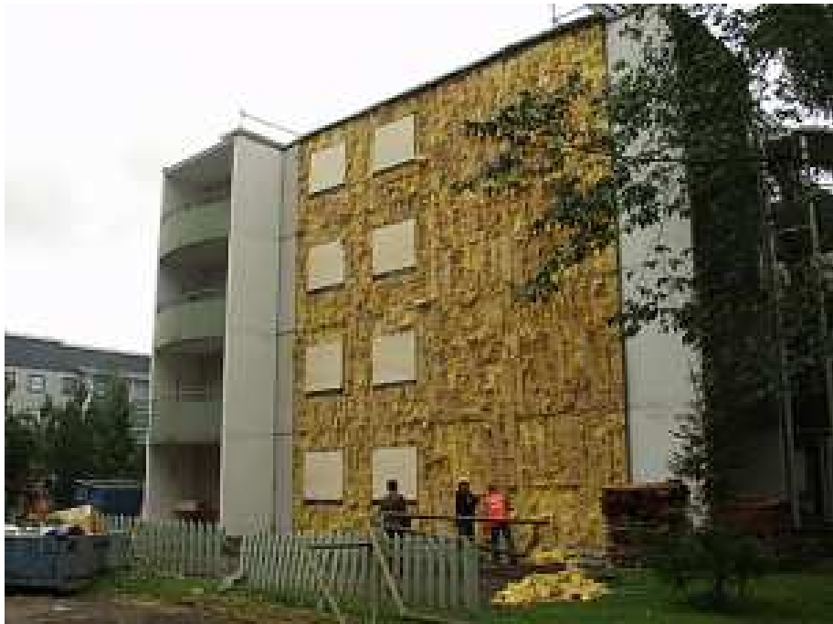
Kuva 16. Vanhan seinärakenteen eristekerros.
