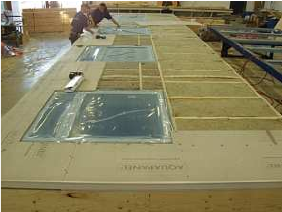
Kuva 6. Aquapanelin asentaminen elementtiin.
